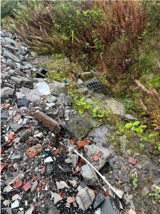
Avrenning til overvannsrøft fra veg som er bygd opp av avfall.
