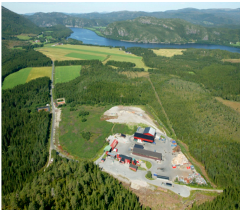
Figur 5. Dronefoto over Stormyra avfallsmottak, sett fra sør (MNA)
