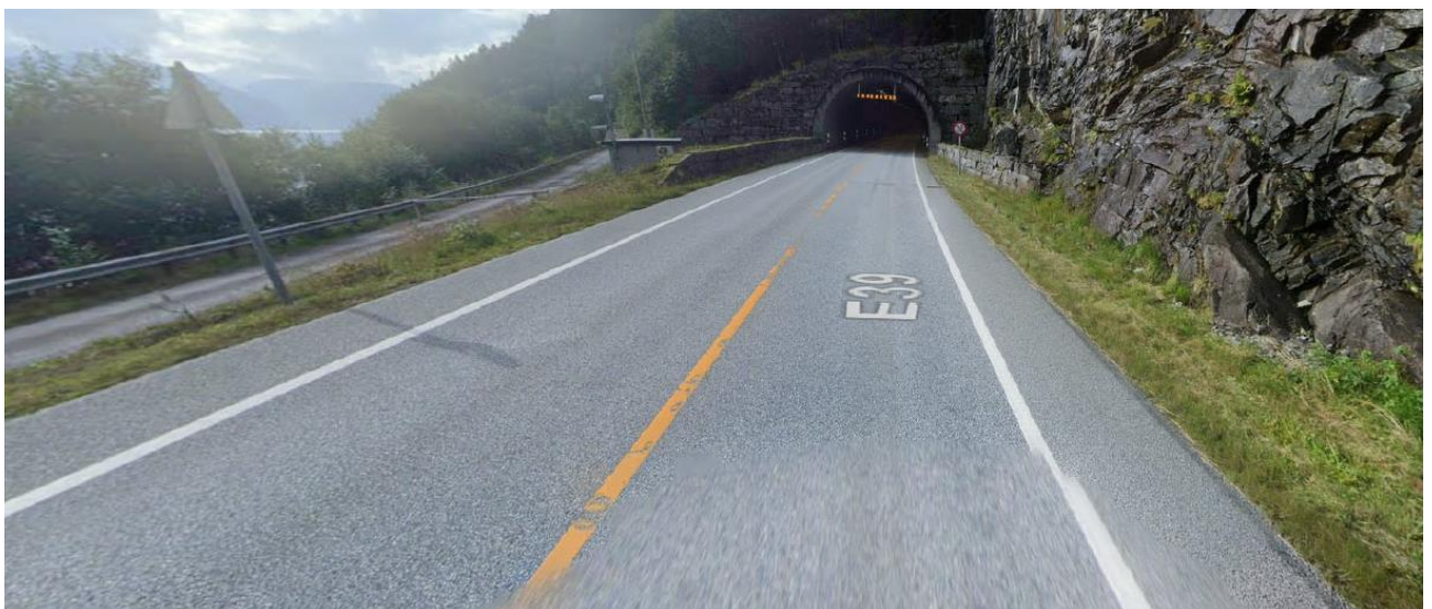
Bilde tunnelportal sør
