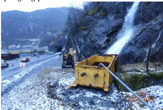
Eksempel containerbasert renseanlegg for E39 Masfjordtunnelen
