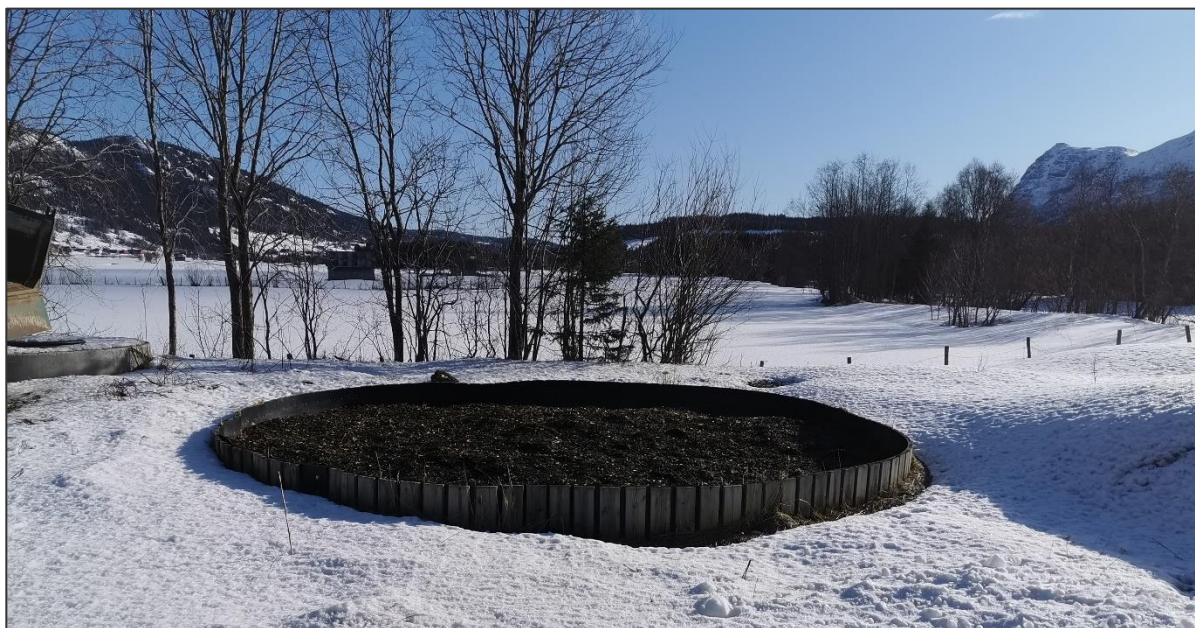
Figur 17. Biologisk luftfjerningsanlegg ved Trøim renseanlegg (barkfilter).
