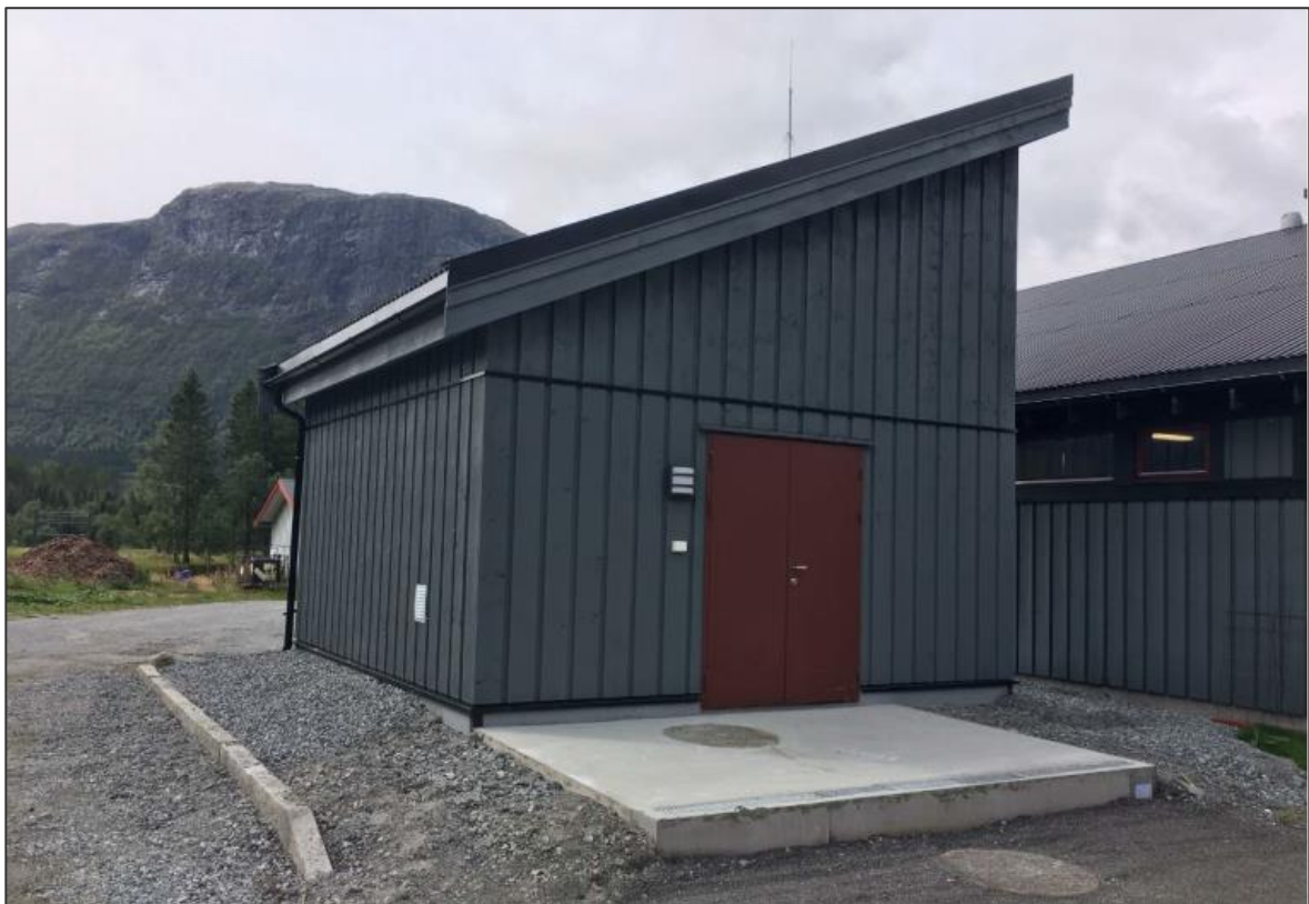
Figur 6. Innløpspumpestasjonen sett utenifra. Nabobygget er Trøim renseanlegg.
