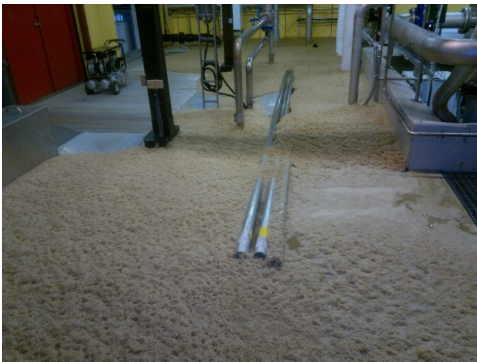
FIGUR 21. EKSTREM SKUMDANNELSE I BIOLOGISK RENSETRINN SOM FØLGE AV INDUSTRIPÅSLIPP. HENDELSEN FANT STED DEN 22.10.2013.
