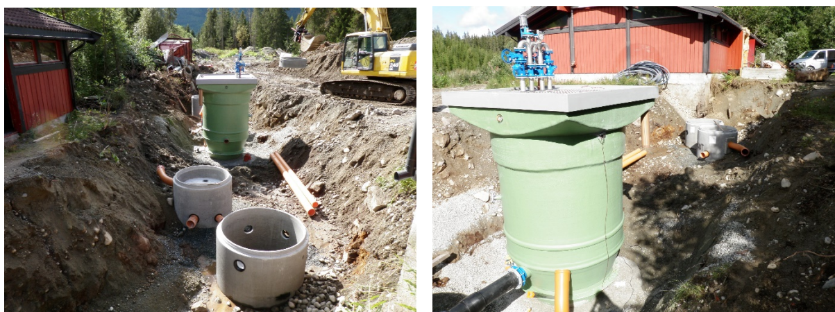
FIGUR 13. BILDER FRA BYGGING AV NY INNLØPSPUMPESTASJON PÅ ULSÅK I 2010
