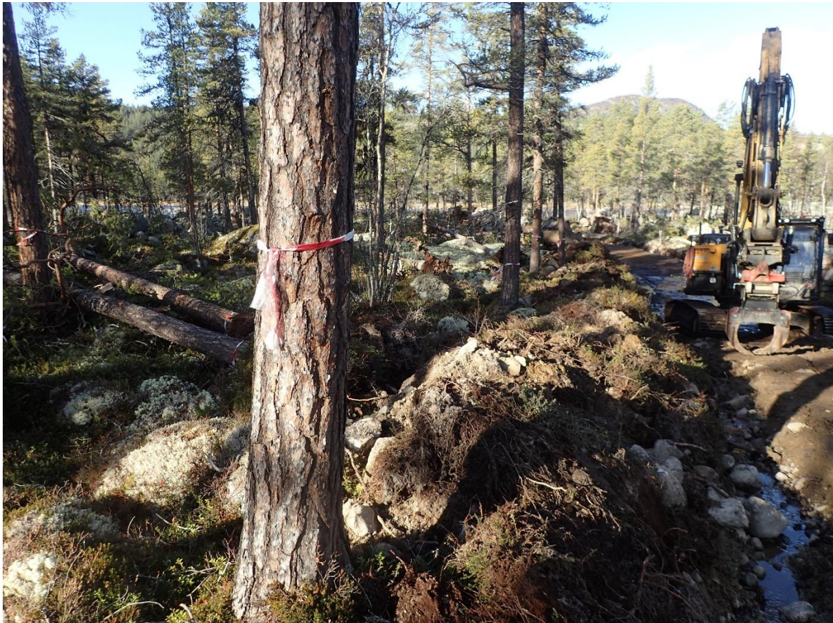
Veibygging til inntak gjennom furunaturskog, der gamle trær og dødvedelementer med rødlistearter er merket for avbøtende hensyn iht. konsesjonsvilkårene. Foto S. Reiso.
