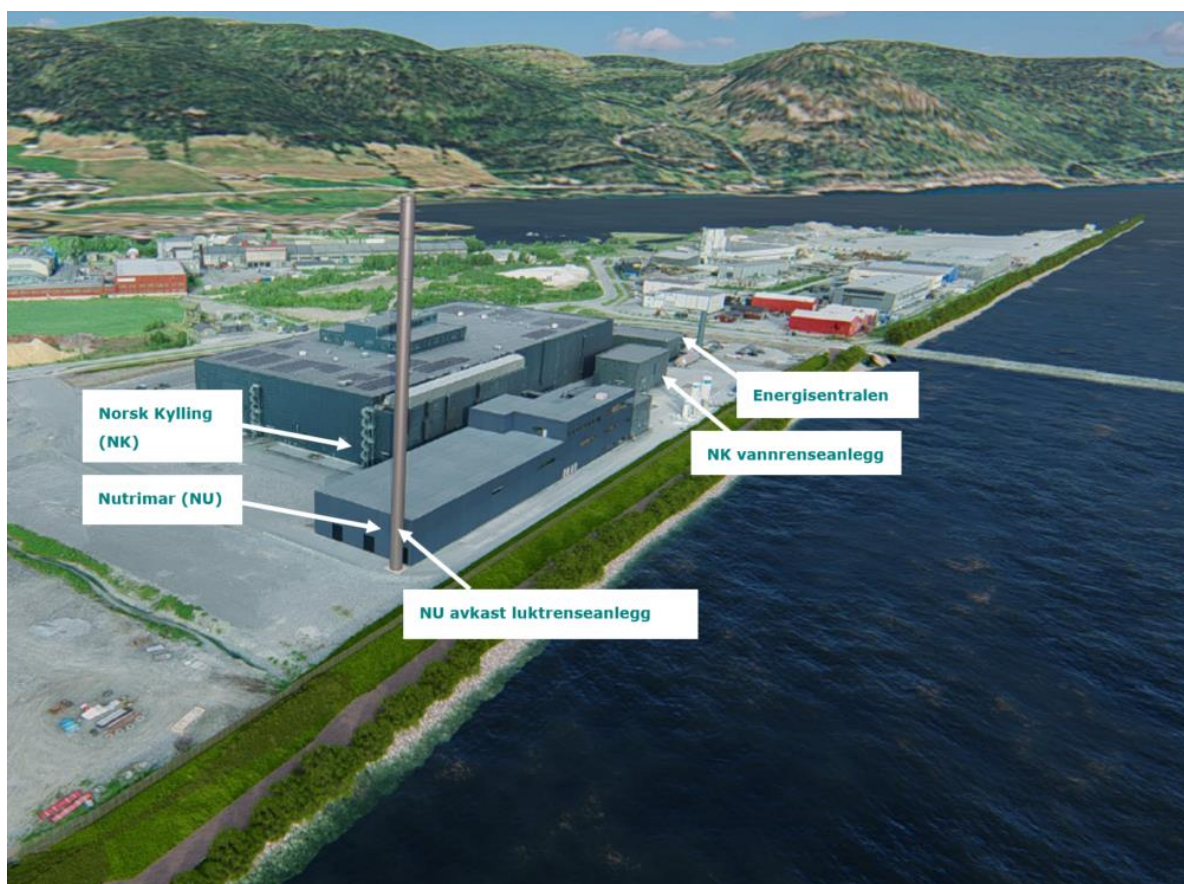
Figur 2: Illustrasjon av det planlagte anlegget til Nutrimar på Furumoen, Orkanger (eiendom med gnr./bnr. 257/340) og oversikt over de andre virksomhetene/enhetene på området. Produksjonsanlegget i bygningen bak anlegget til Nutrimar driftes av Norsk Kylling og de har eget vannrenseanlegg. Planlagt luktrenseanlegg og tilhørende utslippspipe er illustrert i forkant av anlegget til Nutrimar. Energisentralen ligger nord på området.
