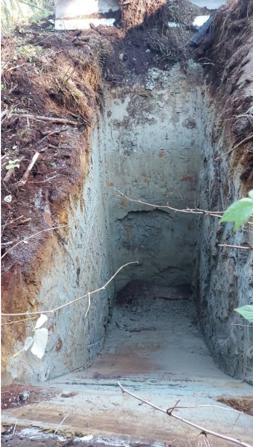
Figur 20 Sjakt 11 ved omlastningshallen.
