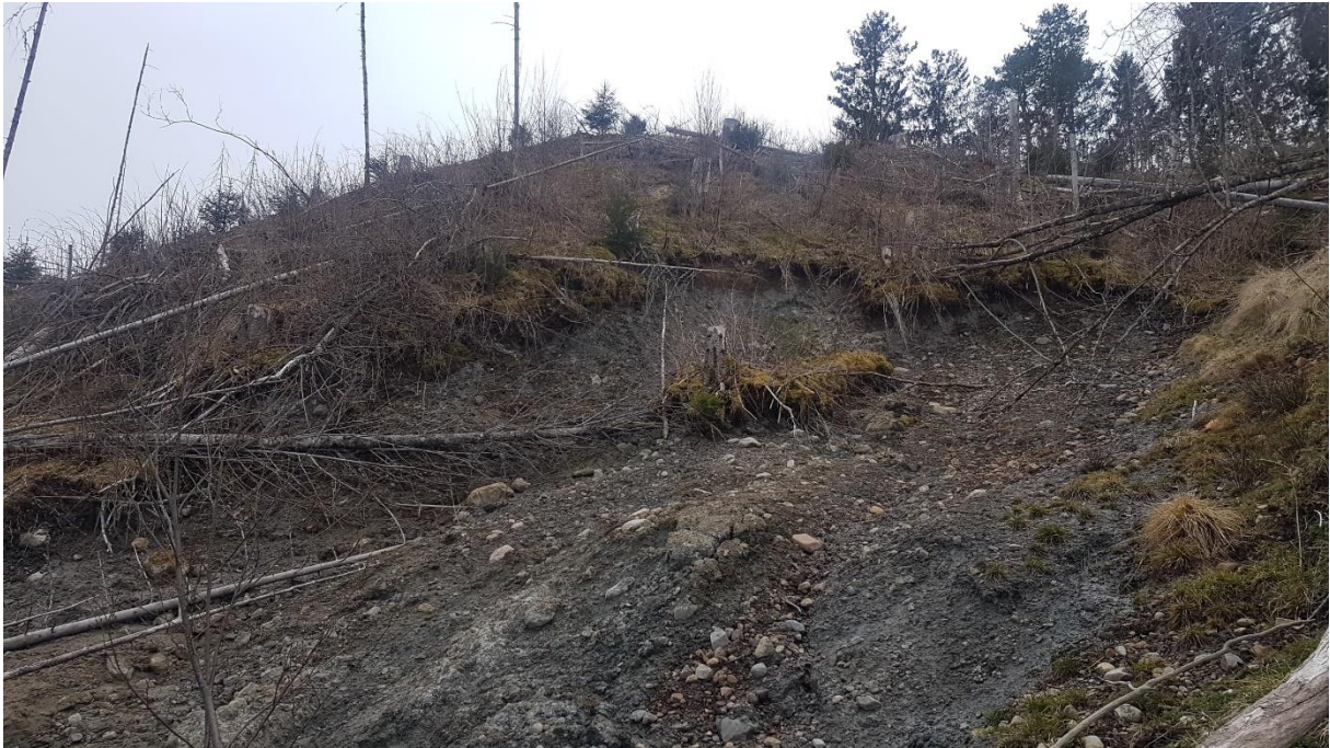
Figur 6. Utglidning av terrenget nedenfor biloppsamling. Det er elveavsetninger i blanding med finkornet materiale, trolig havavsetninger.
