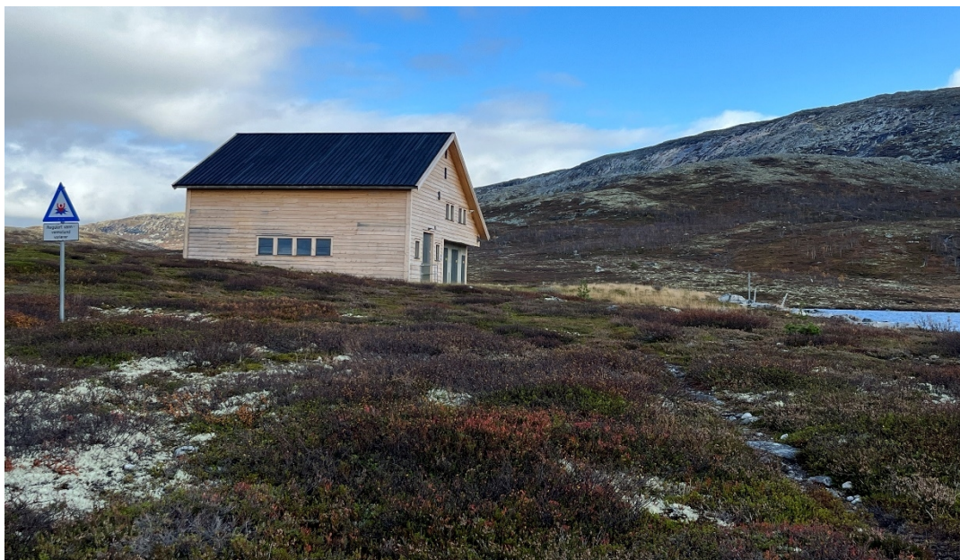
Figur 4 Pumpestasjonen på Viervatn har nyleg gjennomgått eit større vedlikehaldsarbeid. Bygget med pumpestasjonen, demninga og vatnet ligg inne i naturreservatet. Foto: Statsforvaltaren i Vestland/ Maria Knagenhjelm.
