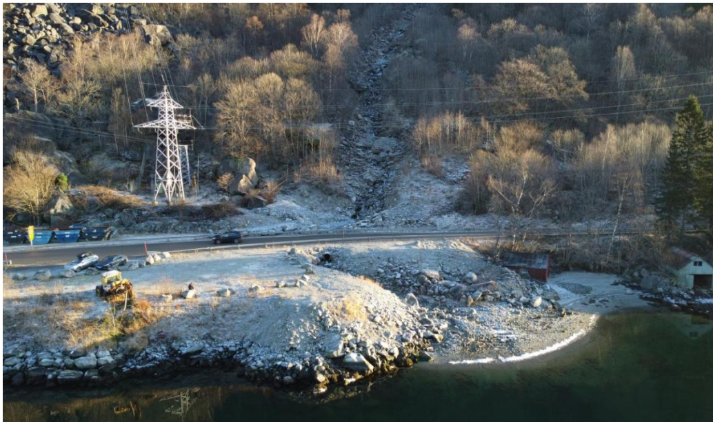
Figur 2 Bilde av utløpet til skredløp nord, avfallsdeponiet er utfyllingen til venstre for kulverten (Multiconsult januar 2025)
