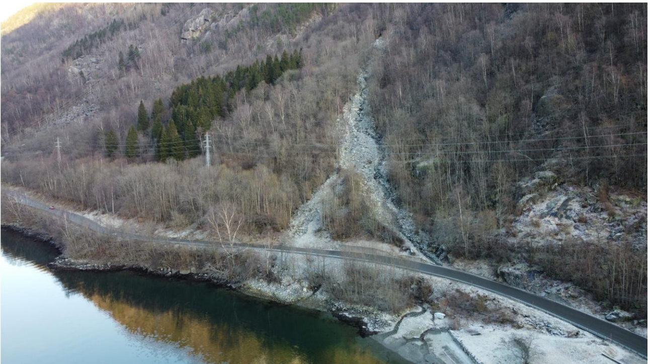
Figur 1-6: Bilete av utløpet til skredløp midt tatt januar 2025. Foto: Multiconsult
