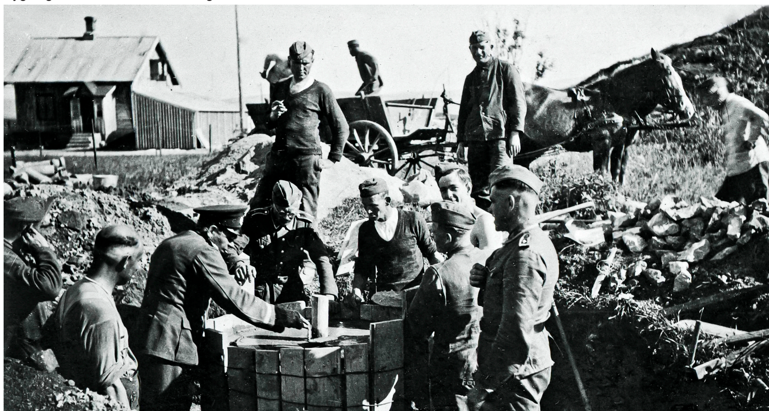
Bygningsarbeider. Enkel forskaling av fundament.
