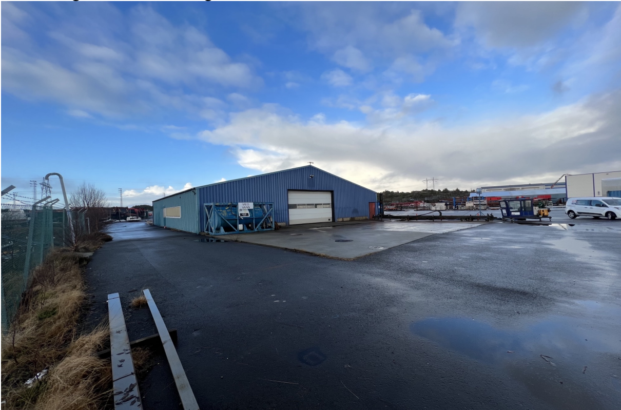
Bleivassvegen 62: Miløsanering av Biler
