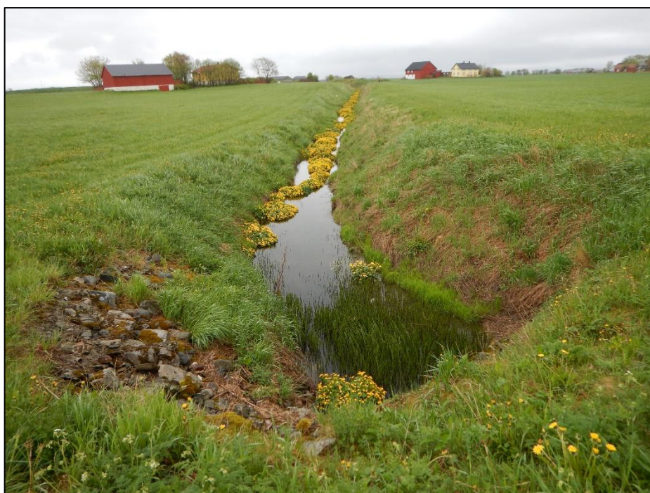
Figur 7. Oversiktsbilde av Meldalskanalen sett mot vest.
