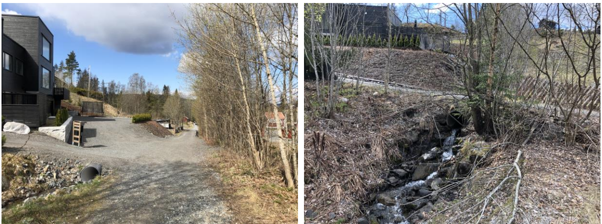
Figur 7-6: Forbi Gml. Ringeriksvei 226. Her er bekk lagt i moderne stikkrenne (mai 2021)
