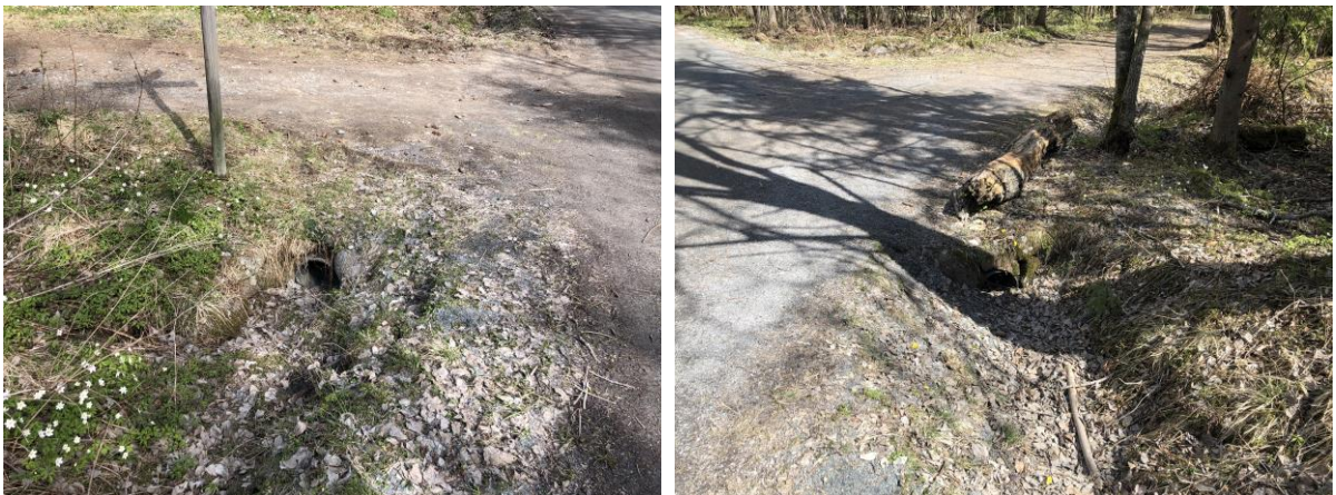
Figur 7-18: Der Knabberudveien krysser Ankerveien er det lagt inn moderne stikkrenner (mai 2021)
