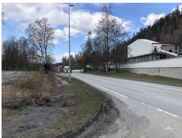
Figur 11-4: Utkjørsel fra Kolsåsbakken (nr. 2b på figur 11-1) er enveiskjørt og ligger på et toppbrekk. Dette gir noe begrensede siktforhold (mai 2021)
