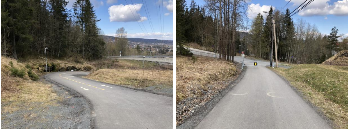
Figur 7-4: Vest i området følger Ankerveien den asfalterte gang- og sykkelveien og krysser under Gml. Ringeriksvei. Høyre bilde viser der Øvre Toppenhaug krysser Ankerveien. Begge bilder sett mot vest, tatt mai 2021
