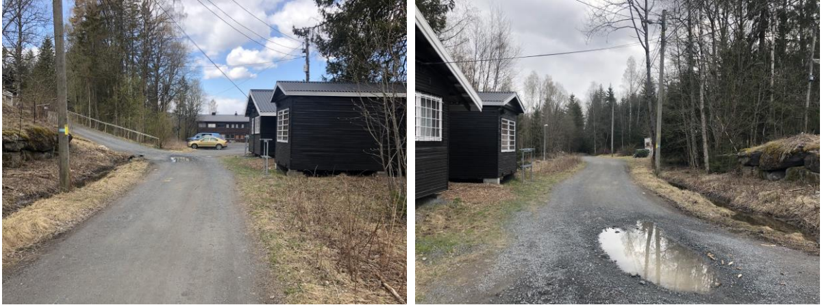
Figur 7-9: Øst for parkeringsplassen er Ankerveien atkomstvei til to boliger. Bilde til venstre viser atkomst til Gml. Ringeriksvei 220, sett vestover. Bildet til høyre er sett østover, og viser atkomst mot Gml. Ringeriksvei 218 (mai 2021)
