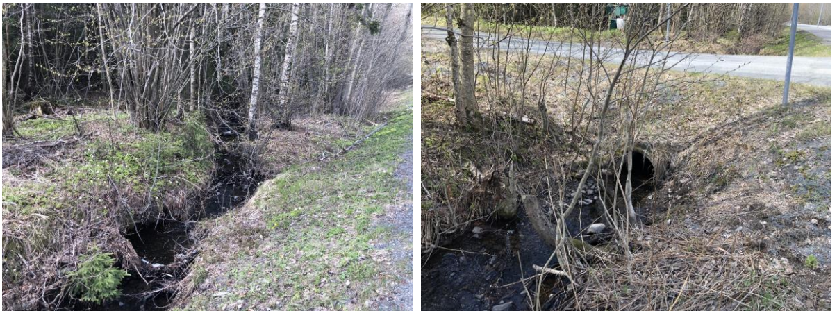
Figur 5-9: Utløpsbekken fra Steinstjern ved Knabberudveien (mai 2021)
