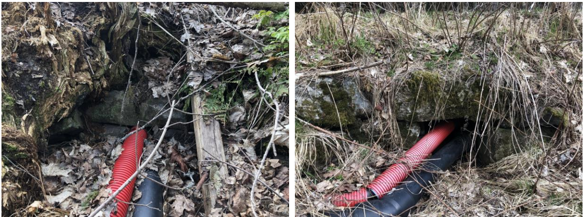
Figur 7-15: Vannledninger er lagt i stikkrenne i Ankerveien. Stikkrenna er trolig original (mai 2021)
