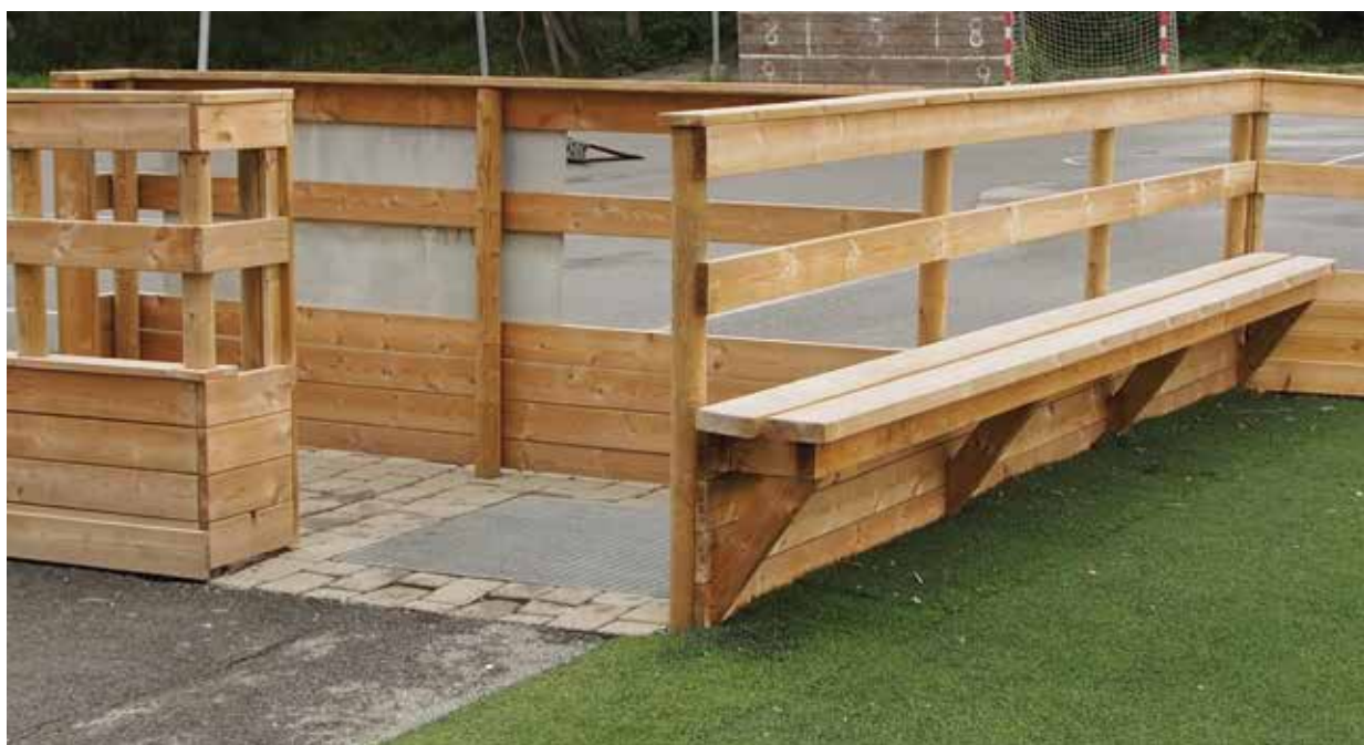
Sluse med granulaterfanger bygget av klubb på dugnad. Granulat samles opp på underliggende kunstgress og vannet infiltreres i baneoppbyggingen. En effektiv og billig løsning. Tangmoen, Stjørdal. Foto: NFF.
