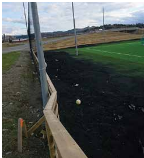
En fysisk barriere er et svært effektivt tiltak for å holde granulaten inne i banen. Gjerdet er satt opp av klubb på dugnad. Foto: Tangmoen IL.
