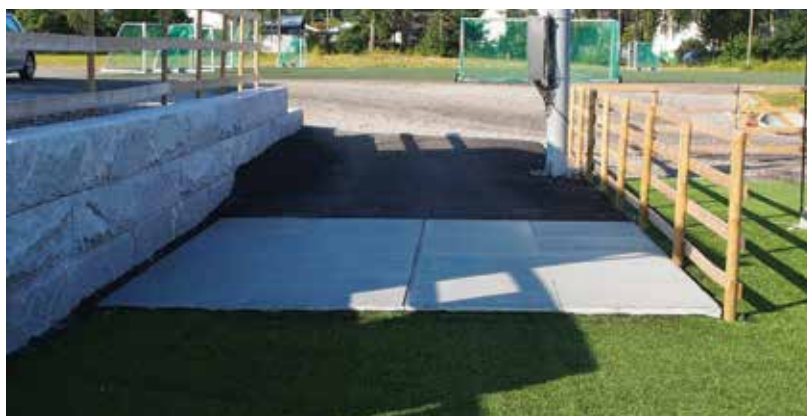
Betongkum med ramme og rist. Kum kan kjøpes ferdig eller støpes selv. Kummen har sluk med granulatfilter i bunn. Foto: NFF/Tangmoen IL.
