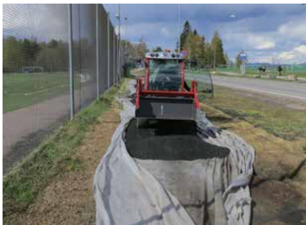
Fiberduk lagt i tillegg gressvoll for oppsamling av snø med granulater. Foto: NFF.
