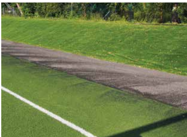
Gressbakken inntil banen er erstattet med landscaping kunstgress for lagring av snø, Skedsmo idrettspark. Foto: NFF.
