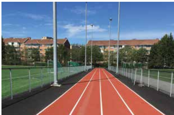
Asfalt og kunststoffdekke mellom to fullstørrelse kunstgressbaner. Kalbakken, Oslo . Foto: Bymiljøetaten Oslo.
