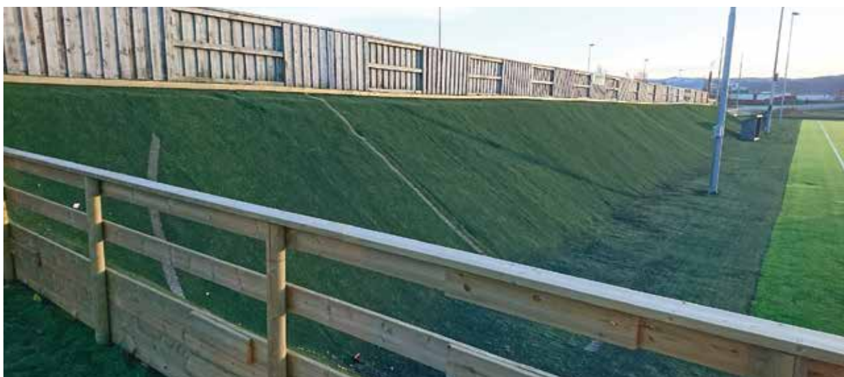
Snødeponi med gjenbrukt kunstgress fra den rehabiliterte banen. Lagt på dugnad av klubb. Tangmoen IL, Stjørdal. Foto: Tangmoen IL.
