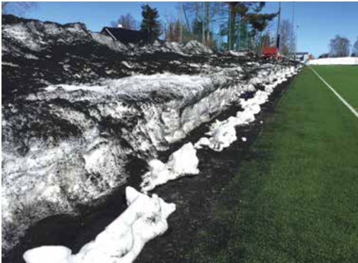
Snø med granulat er brøytet ut på tilgrensende gressplen. Foto: NFF.
