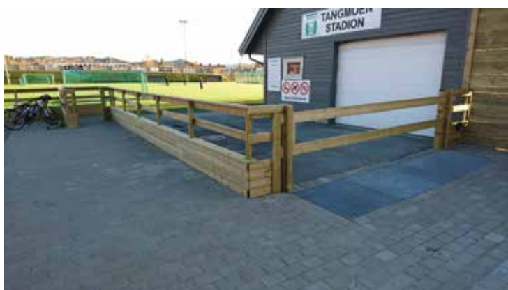
Granulatrensestasjoner med integrerte filter. Denne løsningen krever ikke mekanisk installasjon eller gravearbeider. Foto: Miljøbaner.
