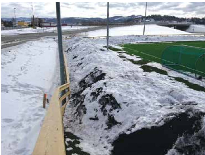
En fysisk barriere er et svært effektivt tiltak for å holde granulaten inne i banen. Gjerdet er satt opp av klubb på dugnad. Foto: Tangmoen IL.
