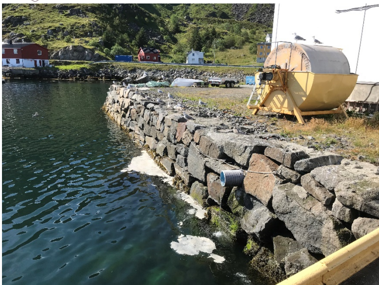
Foto: Fylkesmannen i Nordland. Viser urensset avløp ved Nic Haug AS.
