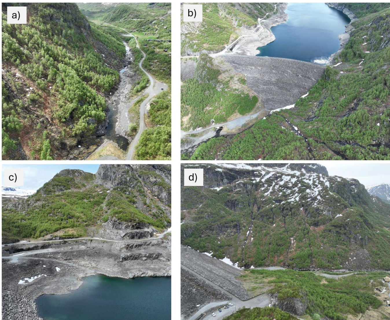
Figur 4: Situasjonsbilde frå tiltaksområdet ved dam Valldalen teke 28. mai 2024. Foto a) viser Storelva i sørvestleg retning, demningen er like under kameraet. Foto b) viser dam Valldalen teke mot nord. Foto c) viser tiltaksområdet der flaumavløp og utbetring av veg er planlagt. Foto d) viser demningen og Storelva i søraustleg retning. (Alle foto: dronfoto Norconsult Norge AS).
