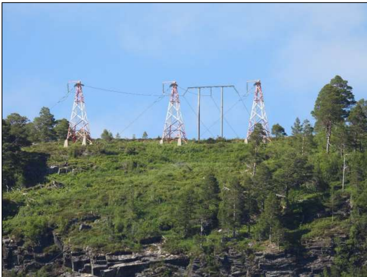
Figur 1 Mellom AS si 132 kV kraftline kryssar området.
