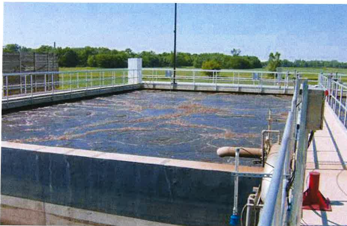
Figur 2-2: Typisk design av SBR anlegg.
