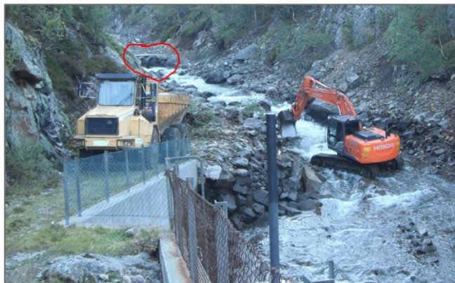
Figur 34: Vedlikehald i Gaukstølåna, røyr med gamal gangveg over elva markert i bakgrunn. Bilde: Statkraft
