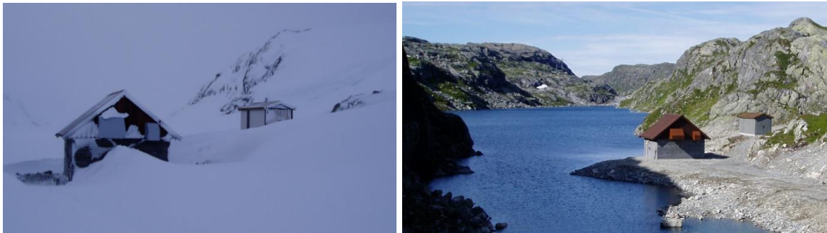
Vatn 1012 og pumpehus
