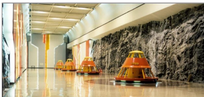
Maskinhall Kvilldal kraftverk
