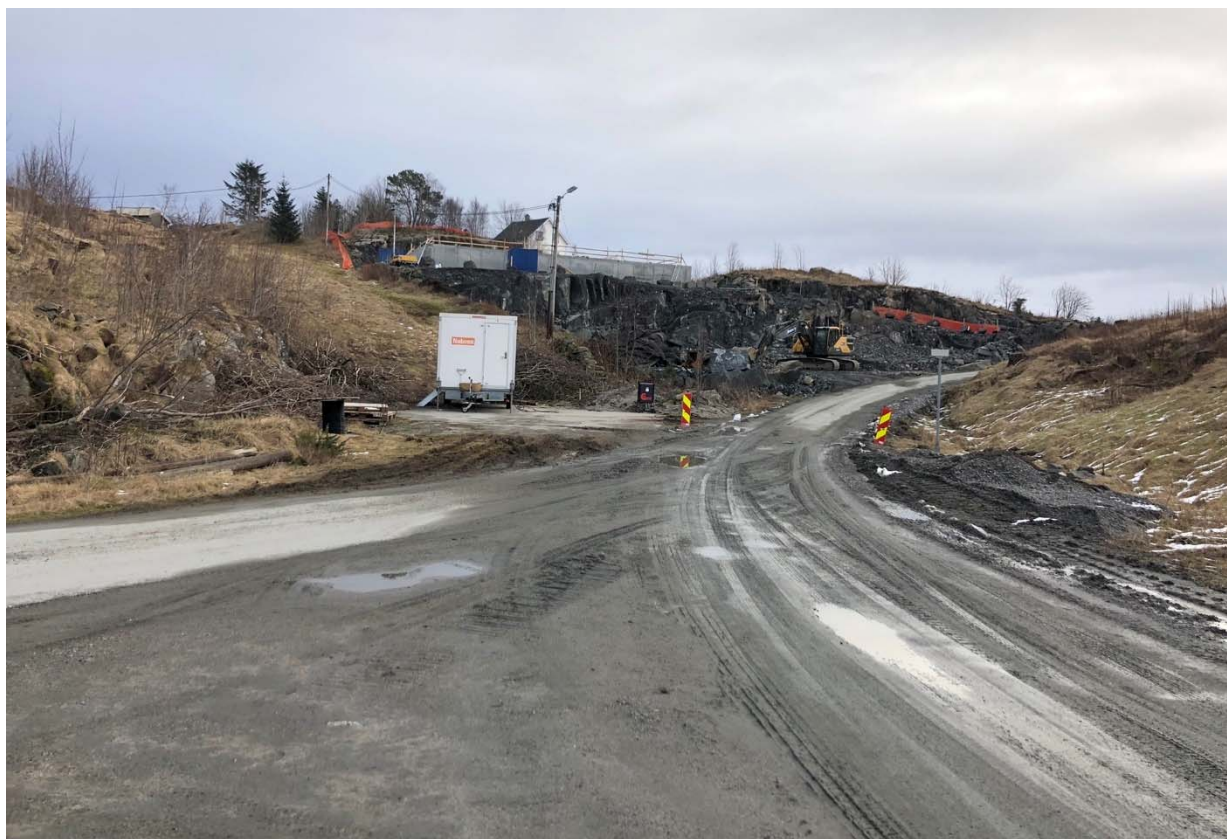
Figur 5-18 Bilde 4, teke frå kaiområdet mot det nye bustadområdet som er under bygging (B1-3).
