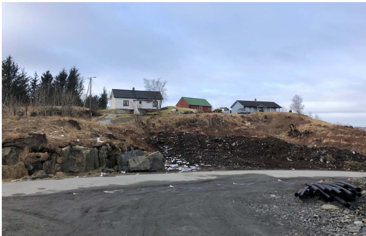
Figur 5-19 Bilde 5, teke frå anleggsområdet på B2, mot eksisterande bygningar i BFS1.
