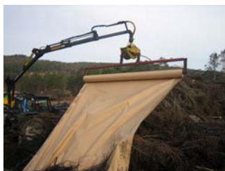
Tildekkast under opplegging, eller seinast i august
