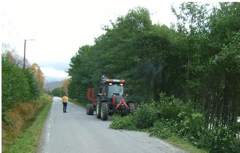
Figur 3. Arbeidsvarsling ved rydding av skog langs veg i Vanylven kommune hausten 2006.
