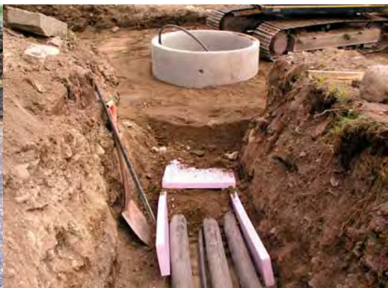
Nærvvarmerør. Foto: Eiliv Sandberg.
