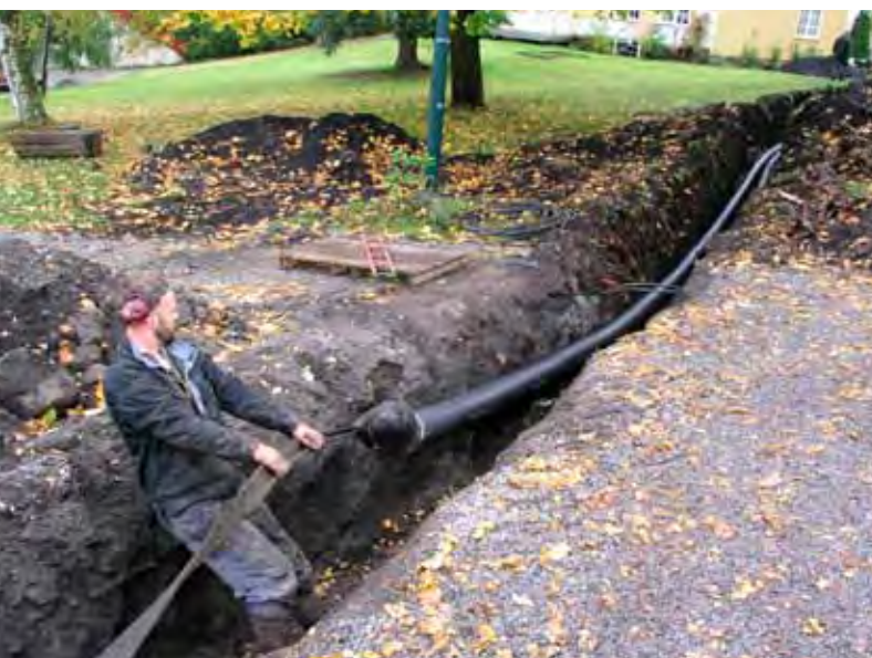
Nærvvarmerør. Foto: Eiliv Sandberg.
