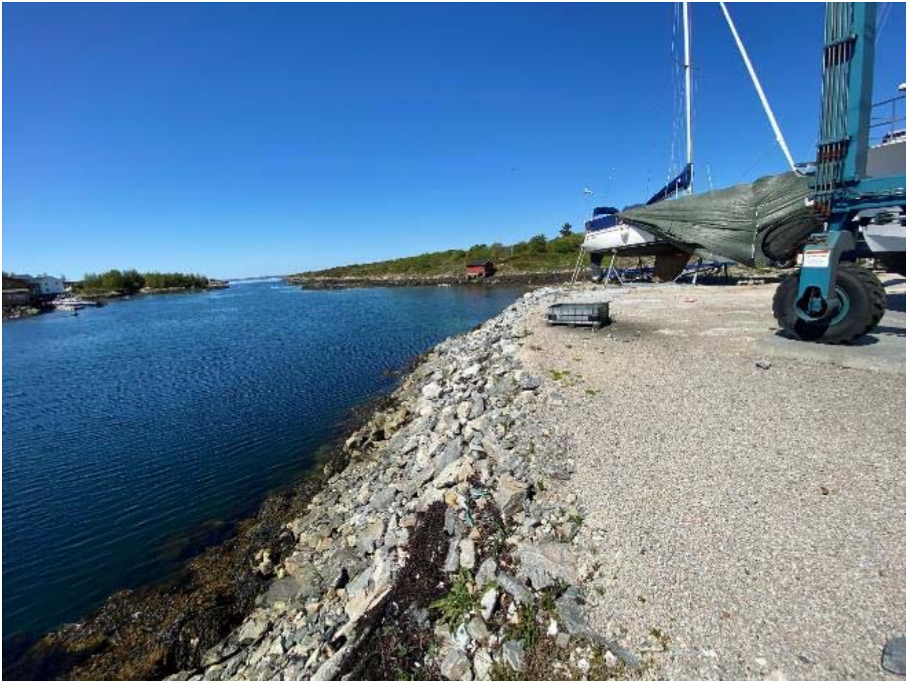
> Foto 8: Dagens fylling og fyllingsskråning mot sørvest
