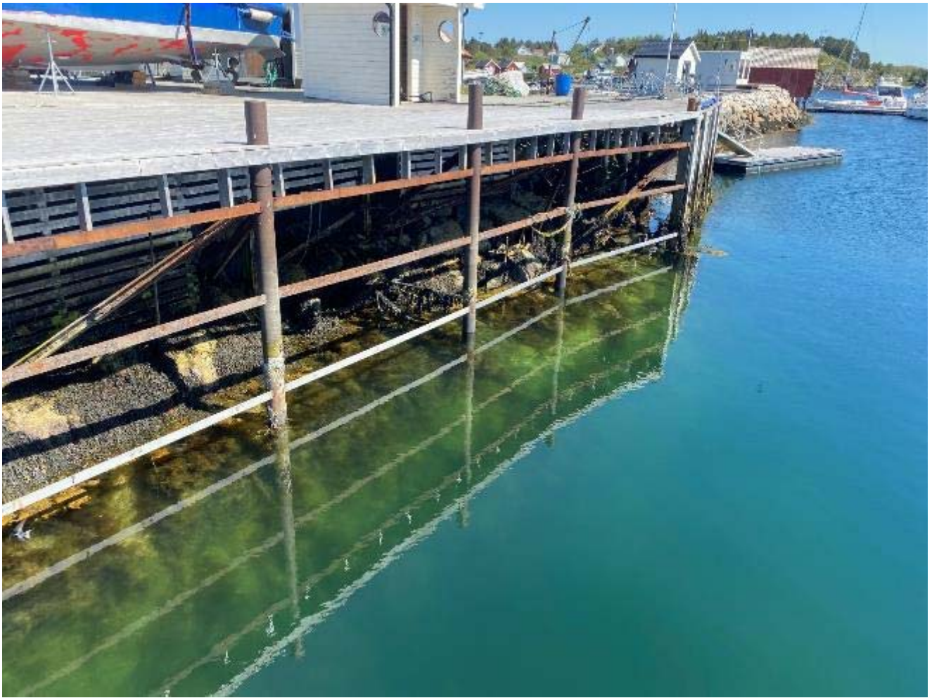
> Foto 4: Blotning av berg utenfor dagens kaianlegg. Kai fundamentert på berg
