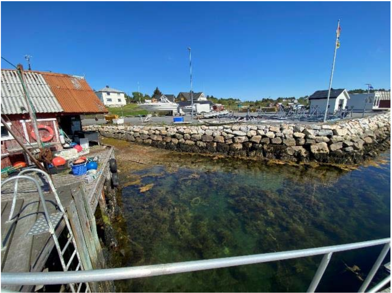
> Foto 3: Oversikt over område 2. Dagens fylling og plastringskråning ses i bakgrunnen
