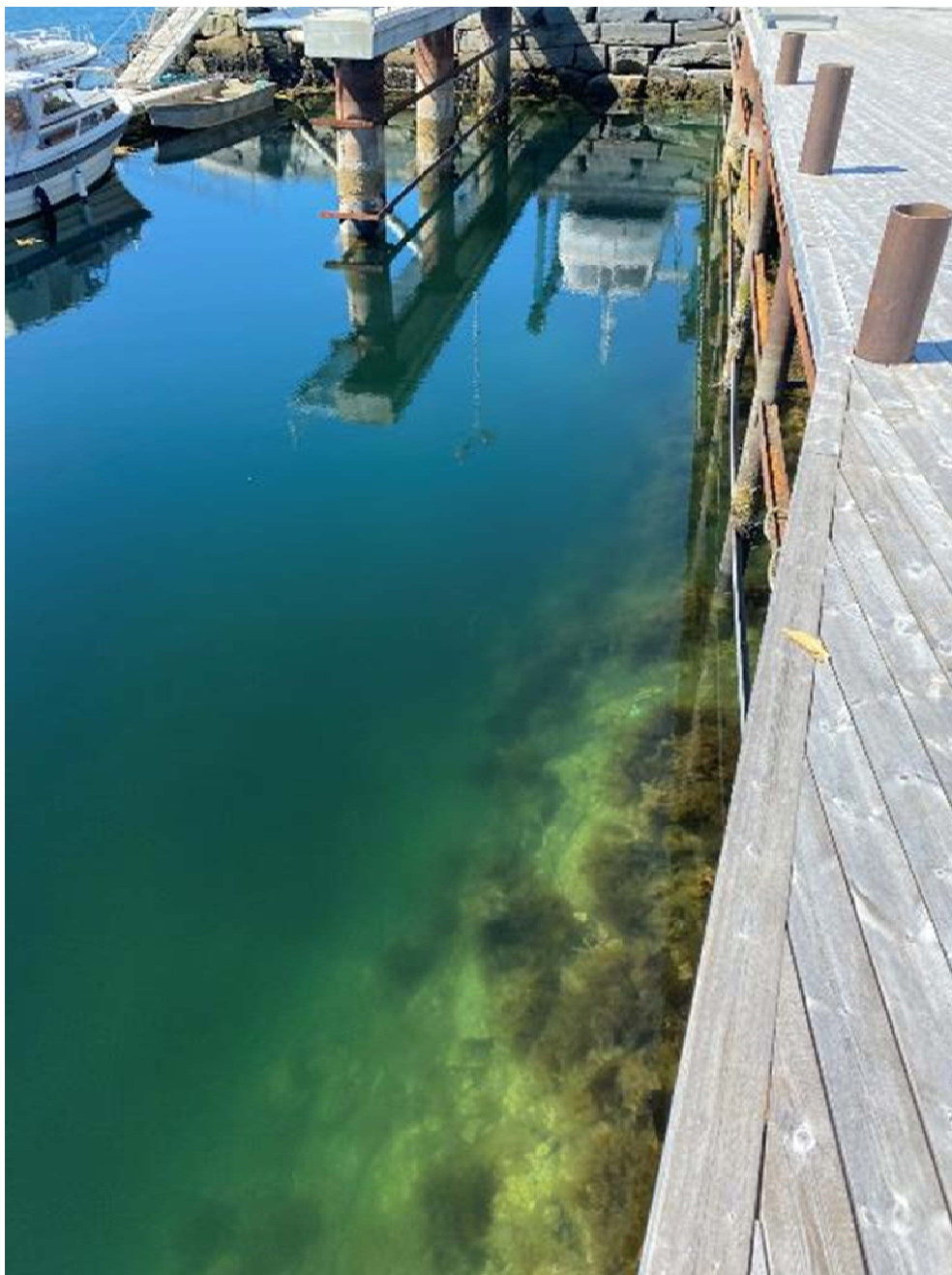
> Foto 1: Kaianlegg fundamentert på berg
