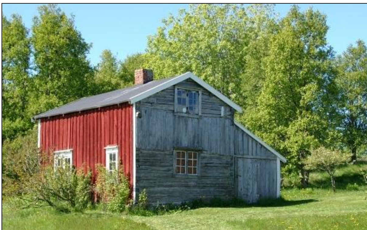
Figur 21. Denne tømmerstua er i god stand og er en av få gamle bygninger på Storfosna og Kråkvåg.
