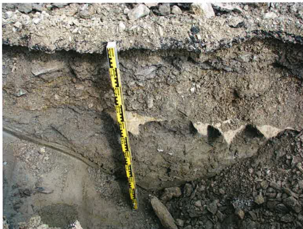
Figur 5. Sjakt 15: Asfalt i toppen, 0-0,6m: Fyllmasser med duk under, 0,6-1,0m: Fast leire
