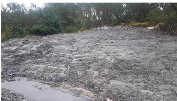
Figur 15. Avsluttet arbeid på oppsiden av sedimentasjonsbasseng.
