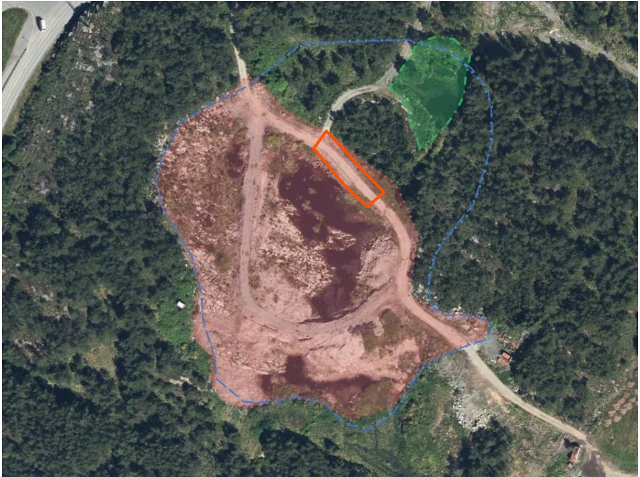
Figur 1 Avgrensning av gravetiltak, fase 1A (vist med blå stiplet linje). Omtrentlig avgrensning av område hvor tidligere deponi lå er merket med lys rød utheving. Grønn utheving viser plassering av tidligere sedimentbasseng. Rød firkant viser område som skal håndteres som masser med risiko for tilstandsklasse 5 (prøvetas).
