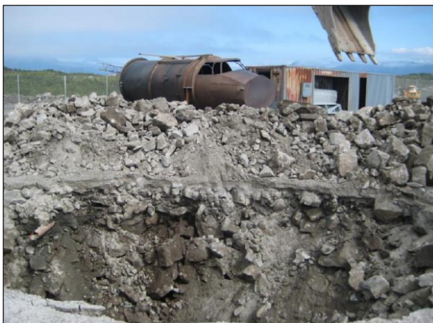
Figur 4 Fyllmasser under BØFA av stein, grus og sand (Sweco/COWI, 2012).
