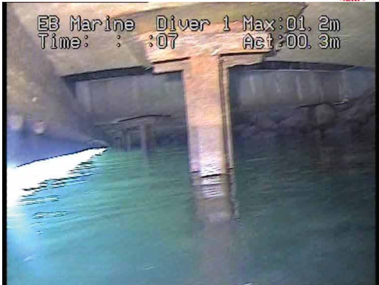
Oversiktsbilde tatt fra VEGG2 og sør.
