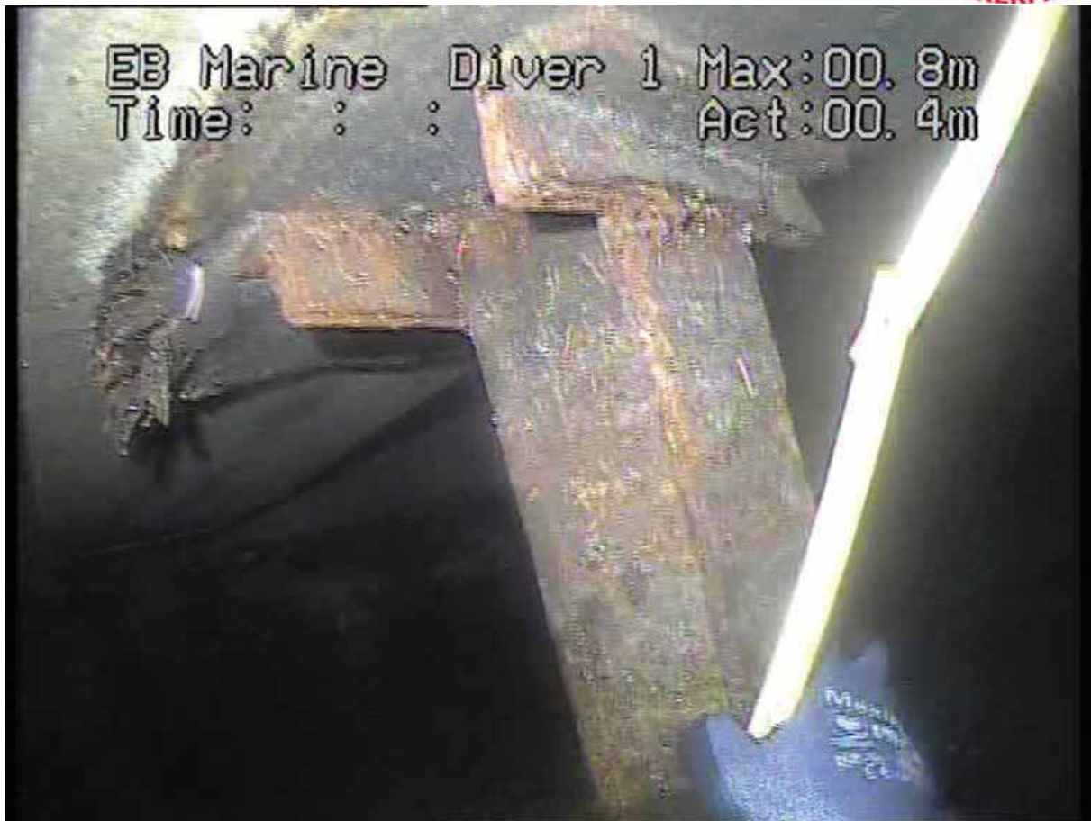
Nærbilde av søylekonstruksjon.
