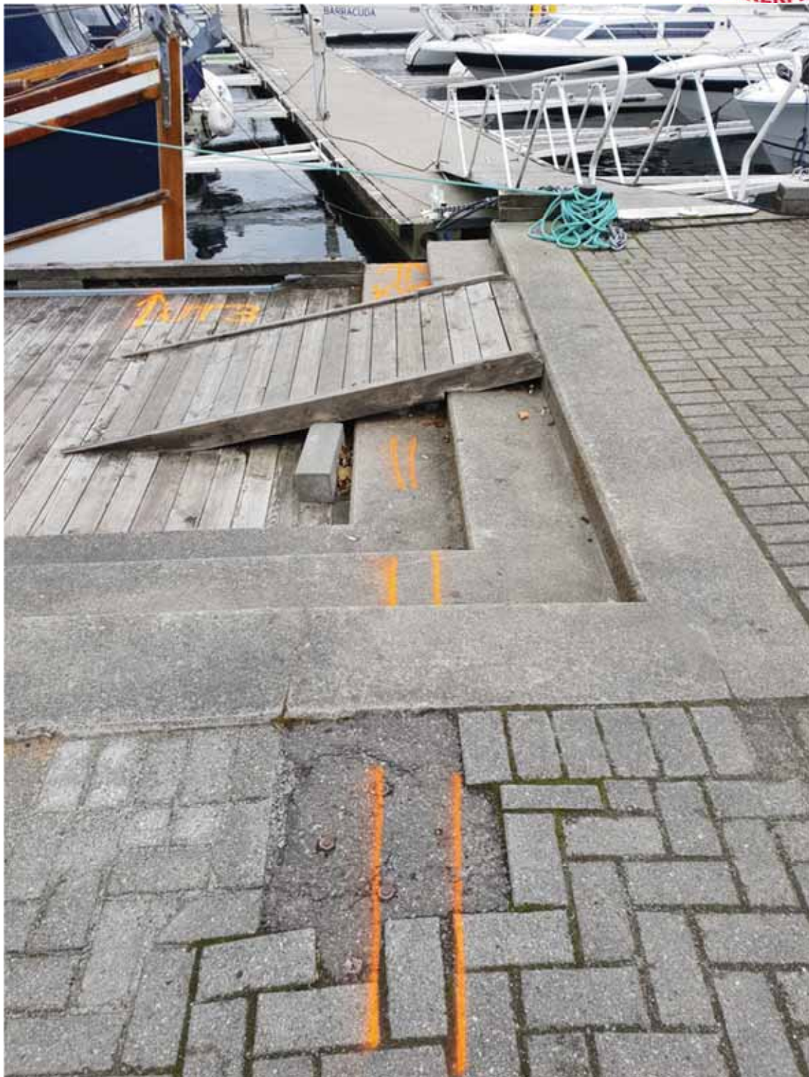
Utslippsledning 3 og Kulvertvegg 1. Kulvertvegg 1 er merket til 6.95m, der vinkel starter.
