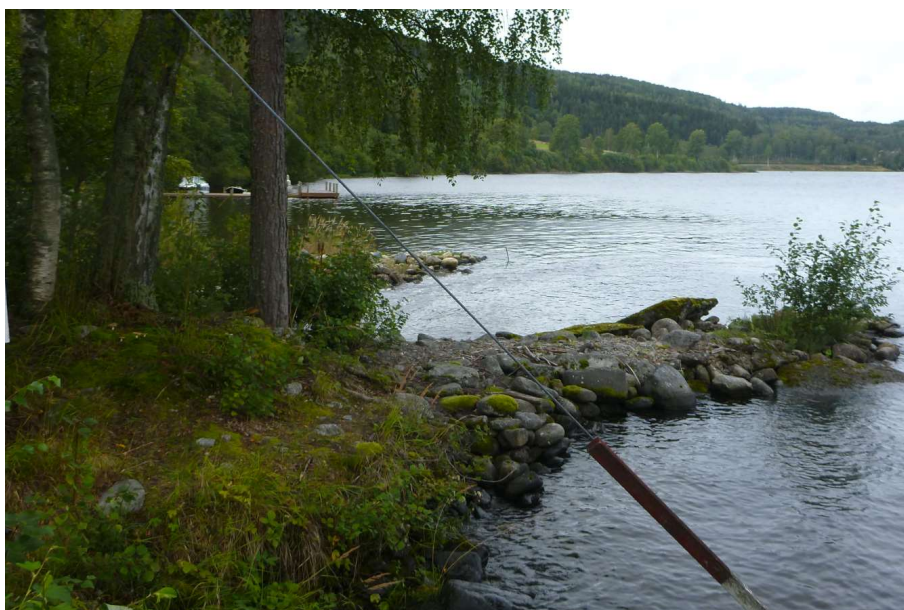
Figur 15: Grytebekkens utløp rett vest for fergeleiet på Tangen. En del større betongblokker er lagt på begge sider av elveløpet ut i fjorden. Foto: Eirik Thorsen
