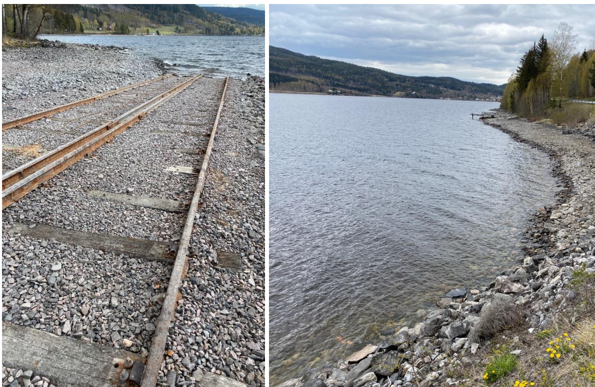
Figur 6: Bildet til venstre viser området hvor slippen fortsetter ned i fjorden. Bildet til høyre viser området nord for Horn ferlegeie hvor det planlegges utfylling i fjorden. Foto: Norconsult AS.
