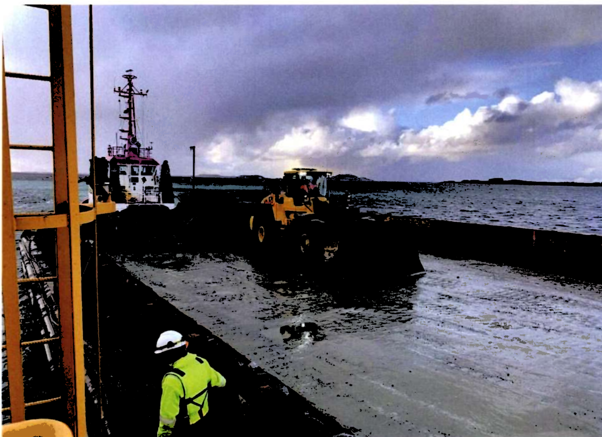
Figur 11: Flattopplekter med hjullaster 10
