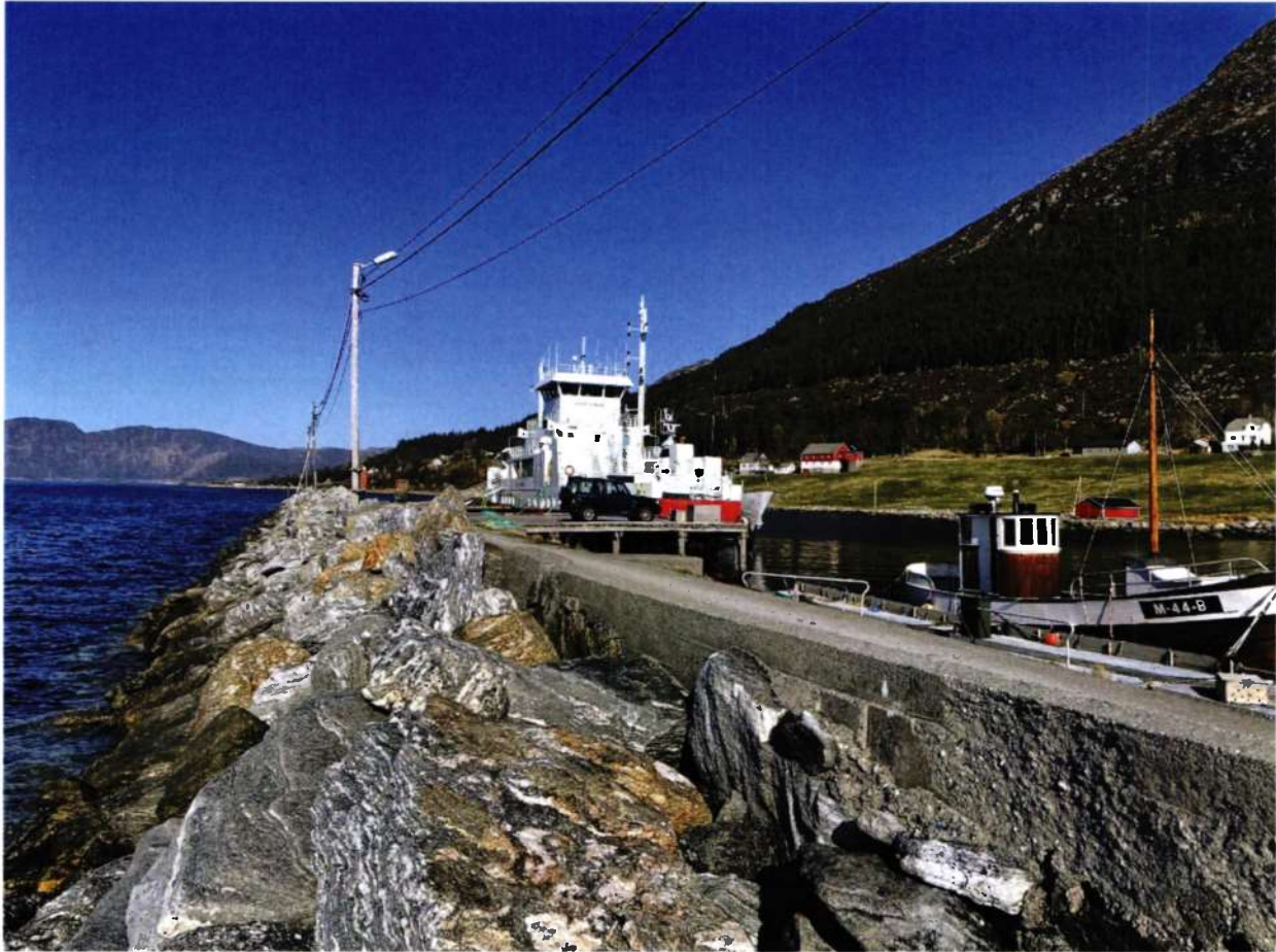
Figur 12 Foto 3 tatt moloens langside mot sjøen. Blokkene er lagt i en plastring og dekklaget later til å være intakt.
