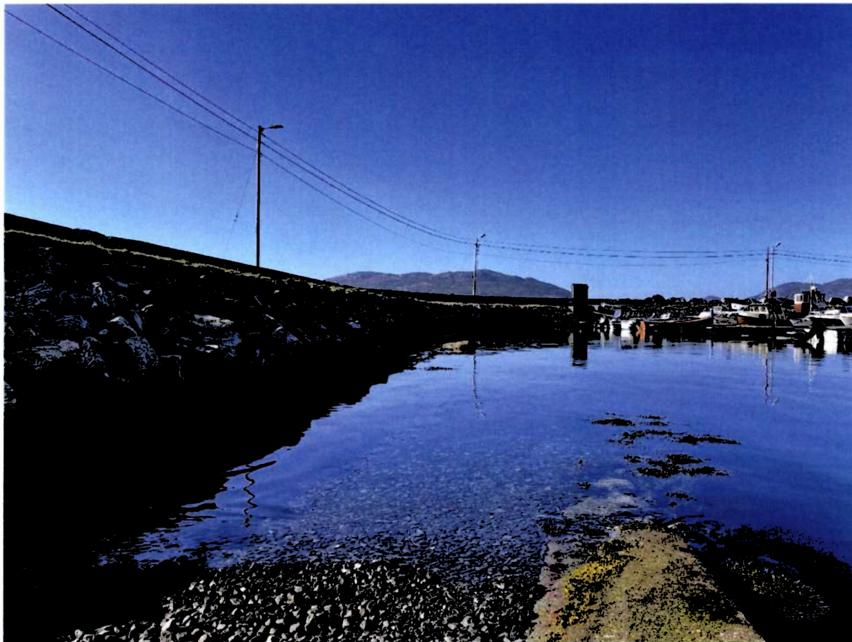
Figur 13 Foto 4 av moloens kortsida inn mot havna. Blokkene er mindre enn på sjøsiden og skråningen ser fin ut.
