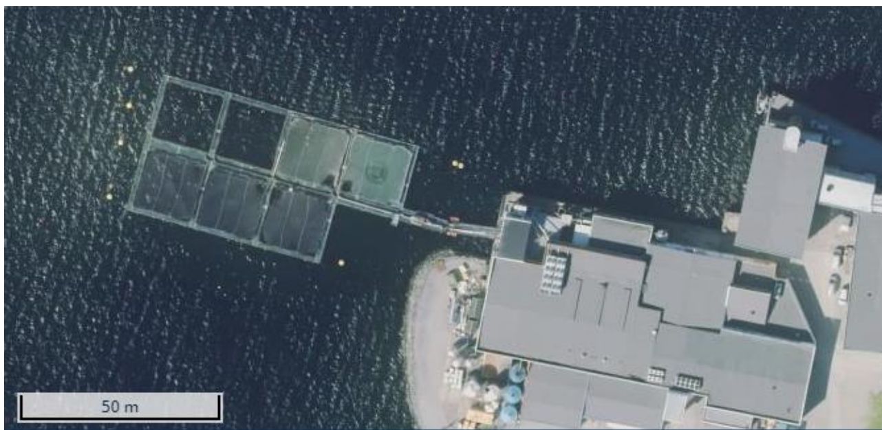
Figur 4 Flyfoto av ventemerden til Slakteriet AS i Førde. Kilde: kystinfo.no
