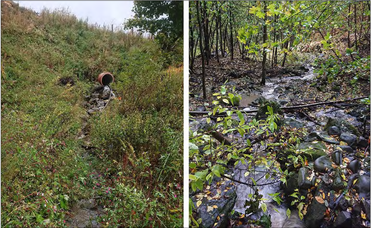
Figur 11. Mælumsbekken går i stikkrenne under dagens E6.
