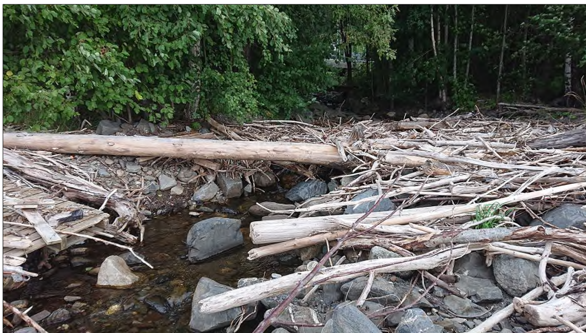
Figur 37. Utløpet av Øyresbekken er tettet med organisk materiale.
