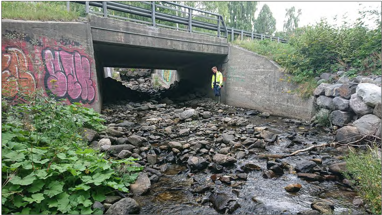
Figur 38. Oppstrøms kulvert med dagens E6-krysning i Øyresbekken. På bildet ser vi kulvert under dagens fylkesveg.
