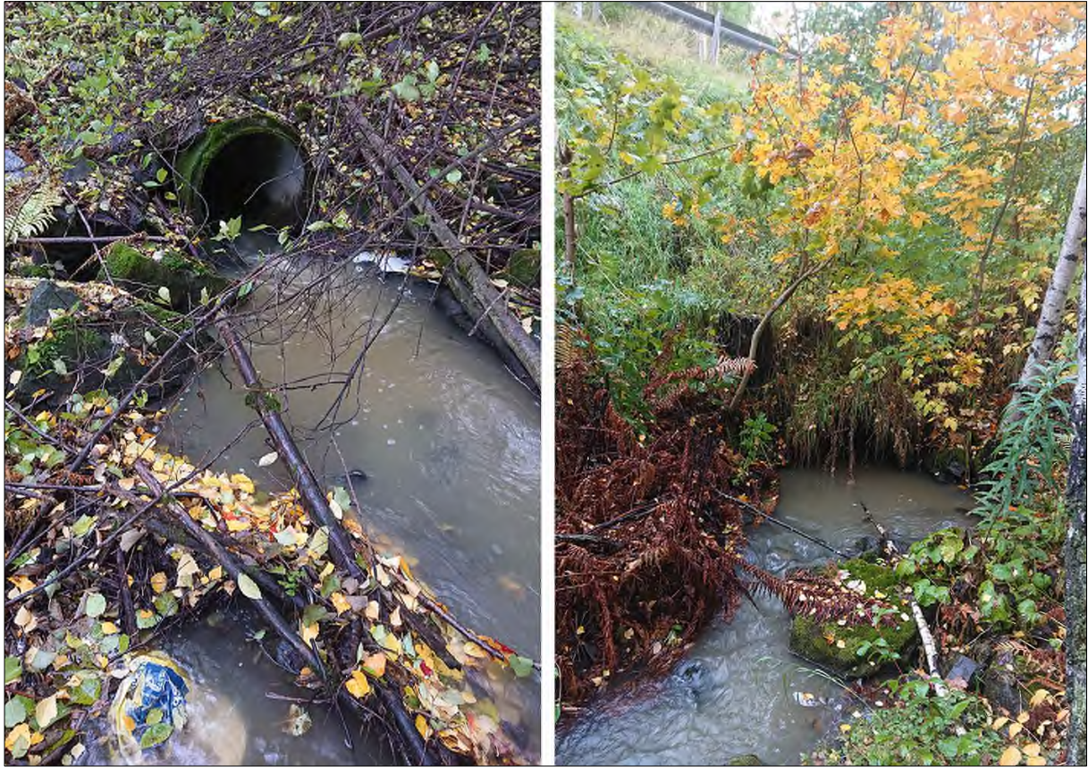
Figur 23. Iversbekken går i stikkrenne under dagens E6.
