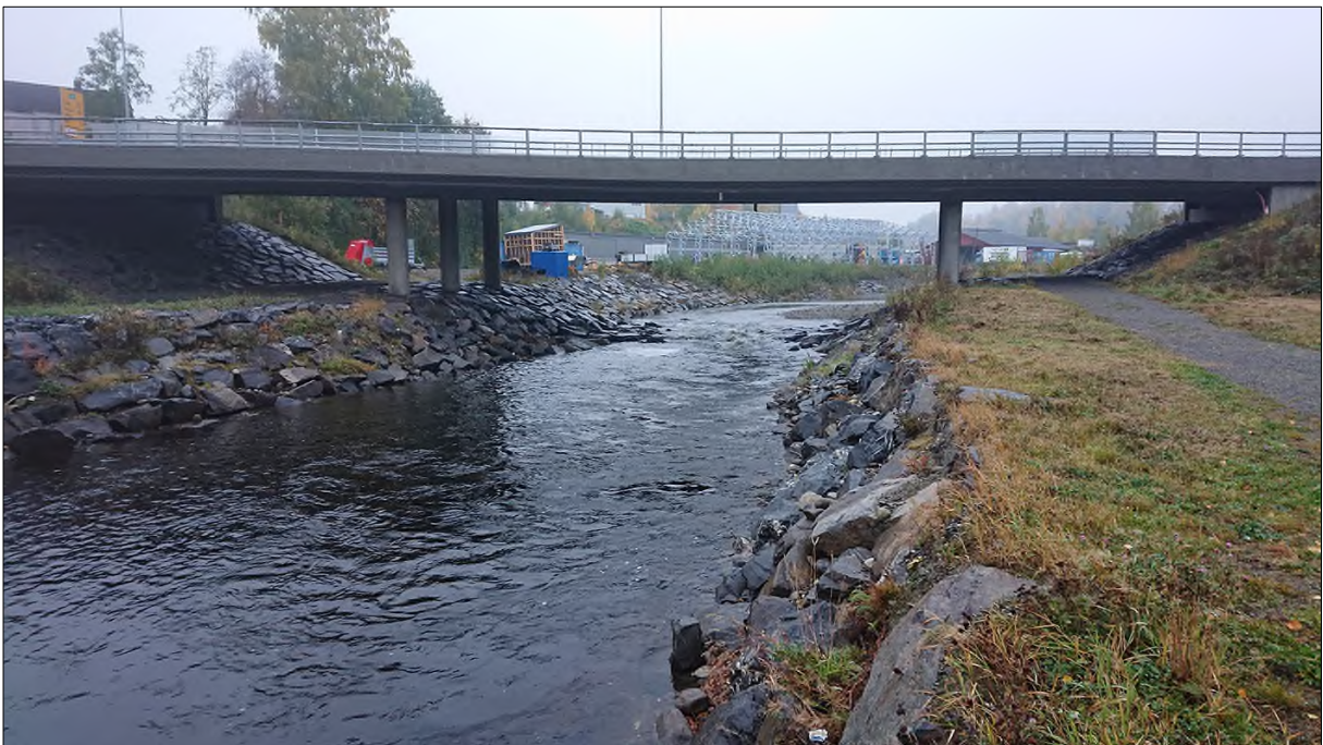
Figur 29. Nedre del av Rinda med dagens E6-krysning er sterkt preget av flomsikringstiltak.
