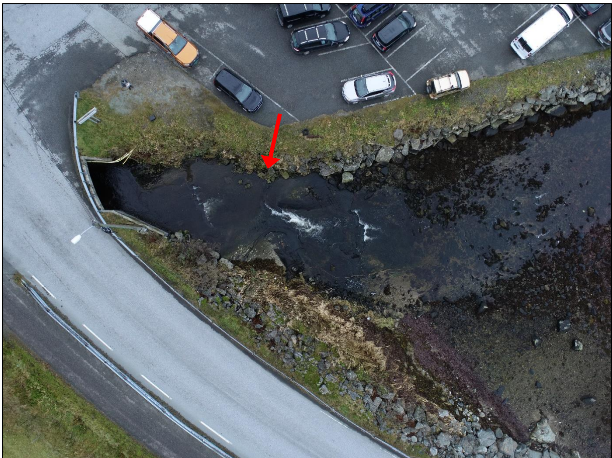
Figur 4. Utløpet av Myklebustelva, sett ovenfra. Den nye utfyllingen skal skrå inn mot dagens utfylling, med indre avgrensning omtrent ved den røde pilen.
