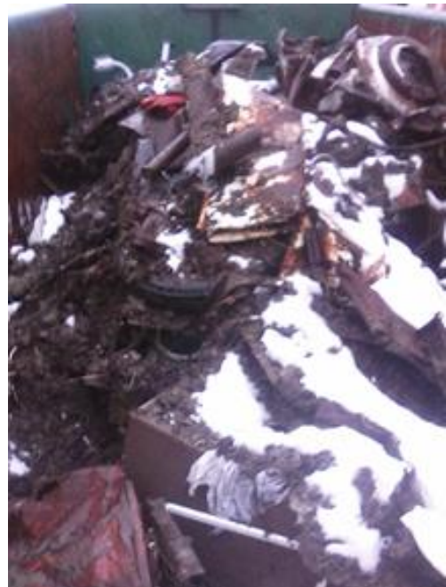
Figur 8. Bilde av oppryddet avfall, område i nord, Nicolai Ulstad, 14.1.2019.
