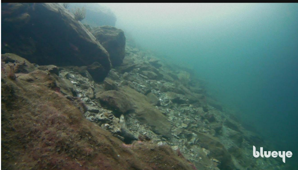
Figur 2. Øvre og nedre bilde: Sjøbunnen i tiltaksområdet er en fyllingsfot bestående av grove steinmasser.
