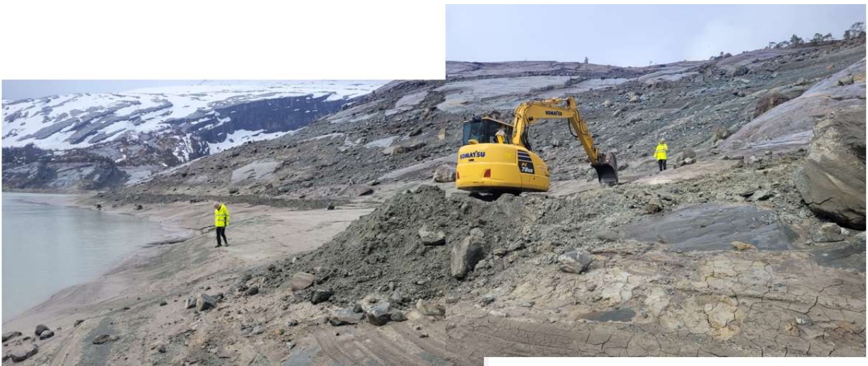
Figur 8. S sammensatt bilde, prøvegraving ved inntaket.
