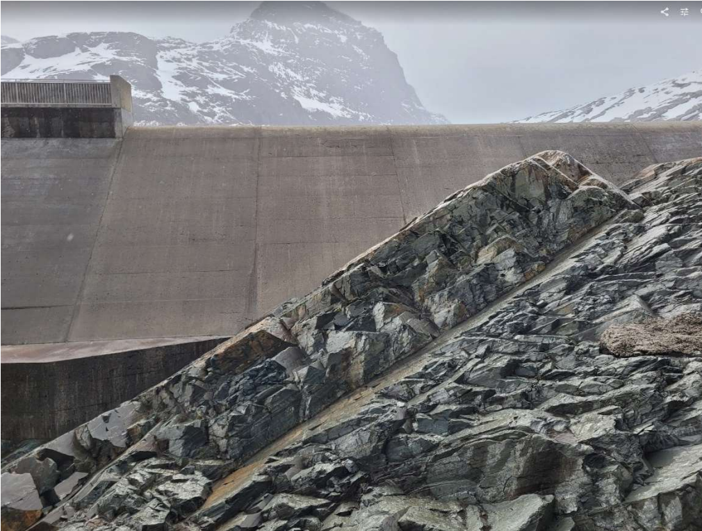
Figur 10. Sprekkesone ved eksisterende dam. Hovedsprekkesettet faller ca. 40° mot øst.
