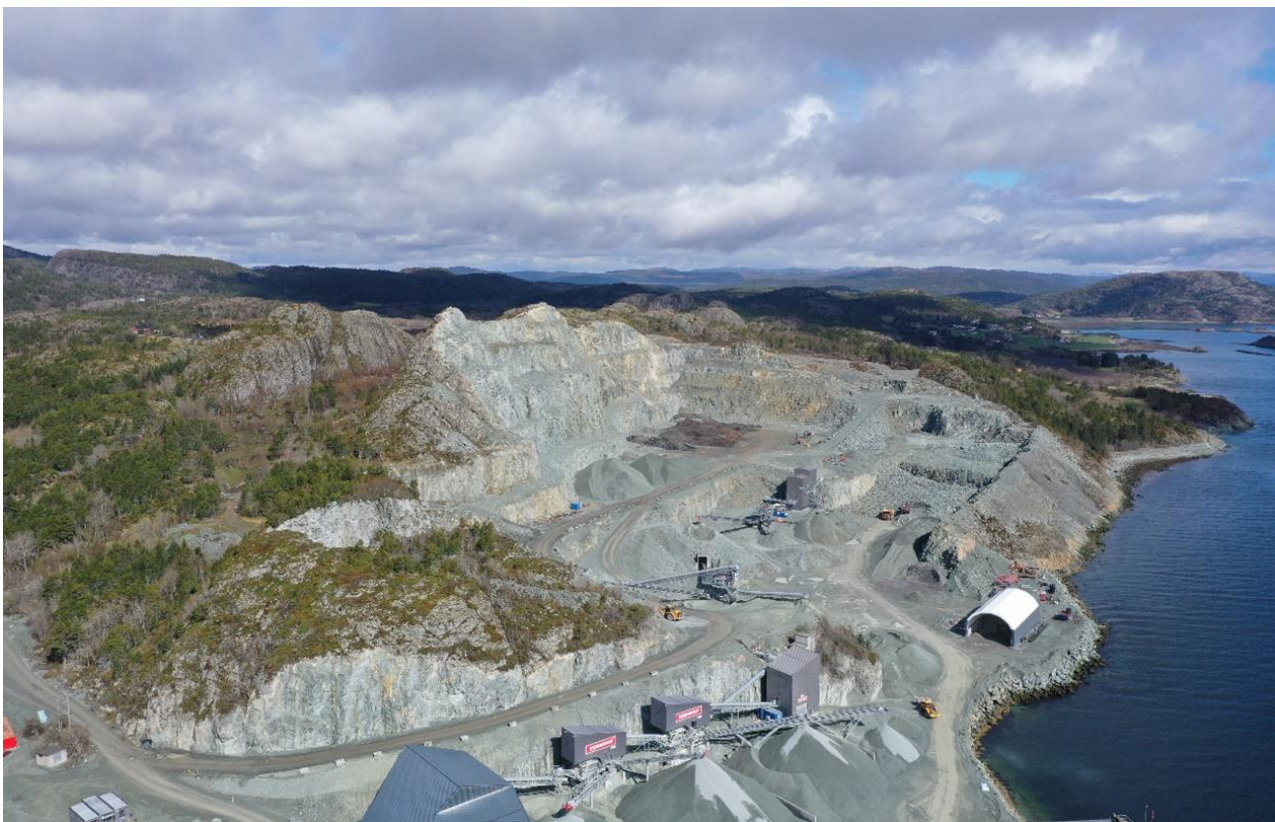
Figur 1: Oversiktsbilde over Ottersbo Deponi og masseuttak
