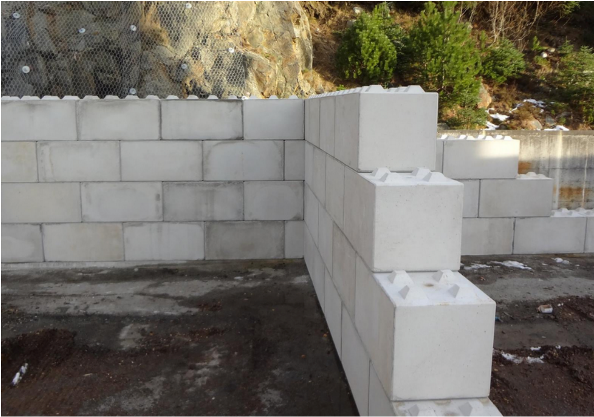
Vedlegg 2 – Illustrasjonsbilde berge av betonglegoklosser
