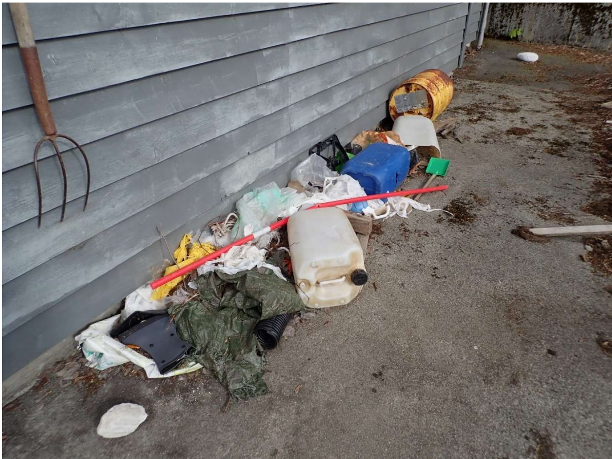
Figur 16. Plast kan tette inntak i vannkraftverk. Her er plast som ble samlet i inntaksristen i kraftverket ved Klekkeriet på Voss. Foto: T.Wiers/NORCE
