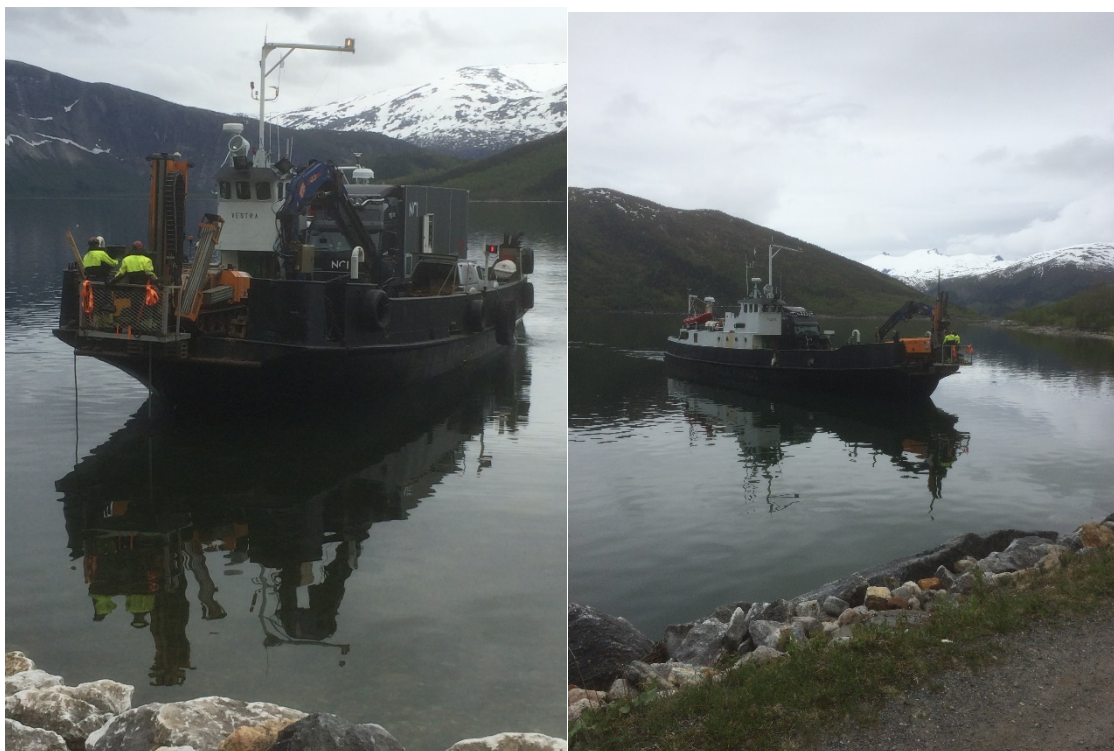
Figur 2. Utførelse av borpunkter fra ferge
