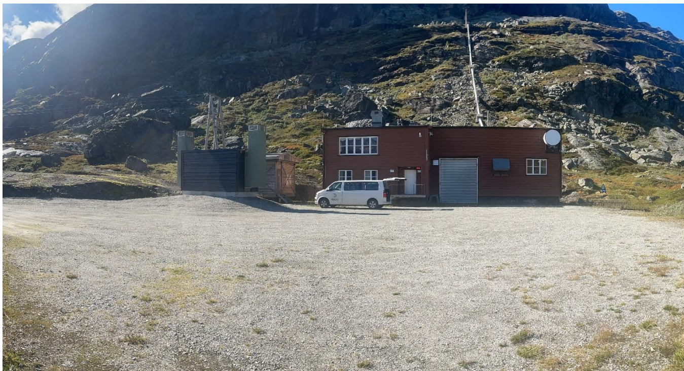
Figur 3-23. Riggområdet ved Fivlemyr kraftstasjon som allerede er opparbeidet.
