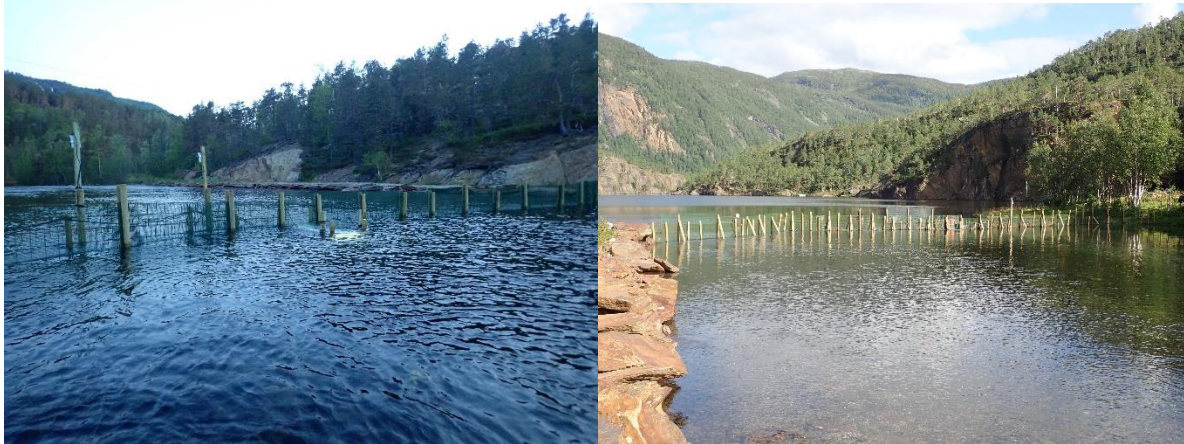
Bilde: Ledegjerdet og videotunnel på utløpet av Litjvatnet.
