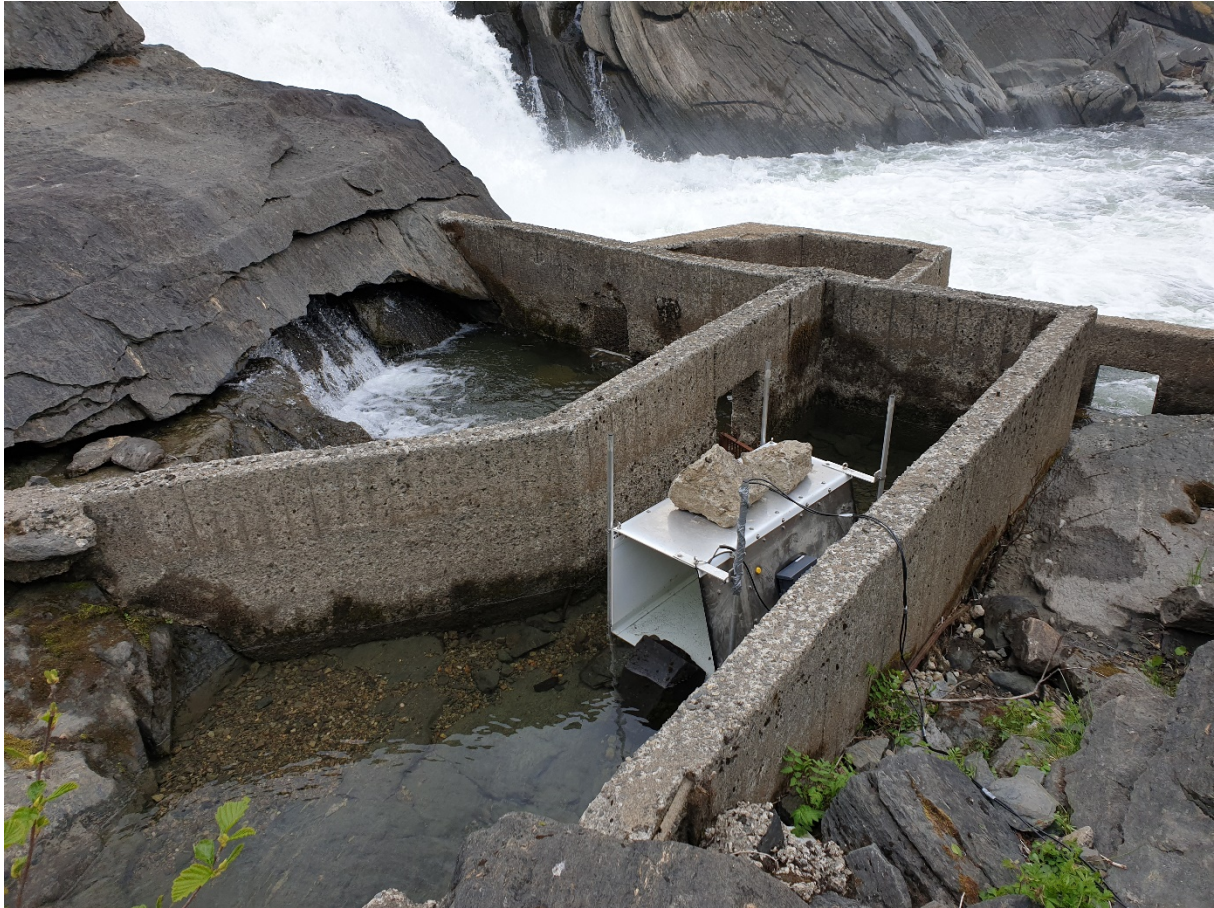
Bilde: Plassering av videotunellen i fisketrappa i Drevja. I forkant av videotunellen er det montert et ledegerje slik at fisken ikke kan passere utenom. Fisketrappa i Drevja. Fotograf: Aslak Darre Sjørusen
