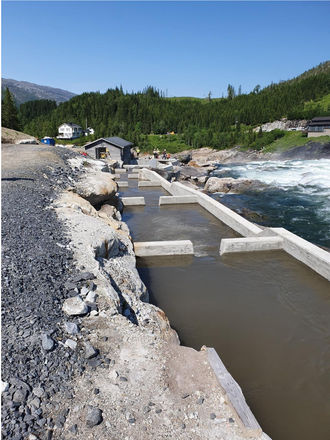
Bilde 5. Den nye fisketrappa i Laksforsen. Huset nederst i bildet er fangsthuset der telleren er montert. Foto: Thomas Bjørnå.
