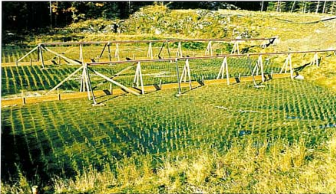
Figur 4. Basseng (4-6) for plantebasert avvanning i tilknytning til det biologiske renseanlegget i Tvedestrand kommune. Bassengene ble beplantet i juli 1988. Bildet ble tatt høsten 1998. Rørsystemet for tildeling av slam sees i bakkant av de to nærmeste bassengene.
