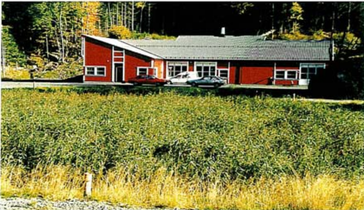
Figur 3. Basseng (1-3) for plantebasert avvanning i tilknytning til det biologiske renseanlegget i Tvedestrand kommune. Bassengene ble beplantet i juni 1977, og har vært i drift siden 19. mai 1988. Bildet ble tatt høsten 1998.
