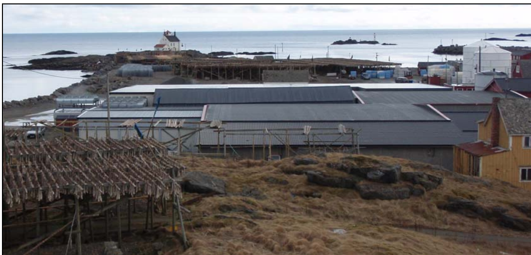
Fig 10 Industriområdet sett mot sør. Industrielokaler er etablert i mellom eldre bebyggelse.
