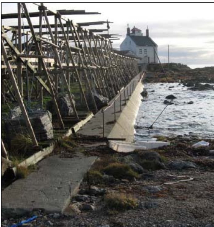
Fig 15 Bilde mot fyret, mot sør, med støpt gangveg til fyret i vest, mot sjøen.
