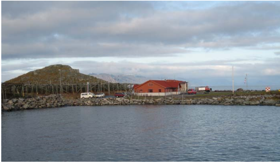
Fig 6 Foto Håkjerringvika m. helikopter-terminal, sett mot nord.
