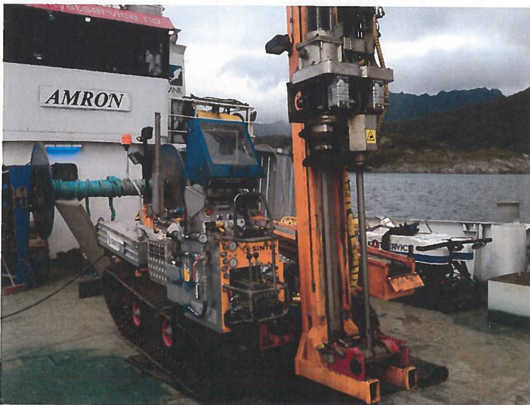
Figur 12 Borerigg Geotech 504 ombord på Amron.
